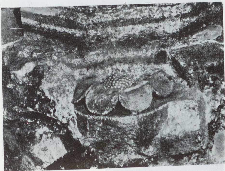
30. Zárókő a második építési szakaszban készült szentélyből
