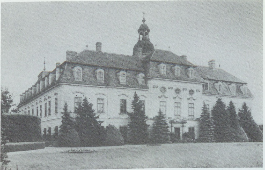
121. A cseklészi Esterházy-kastély kerti homlokzata
