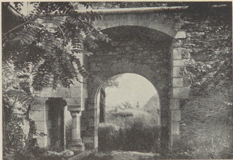
A Ny-i nagy Zwinger kapuja belülről a helyreállítás után
