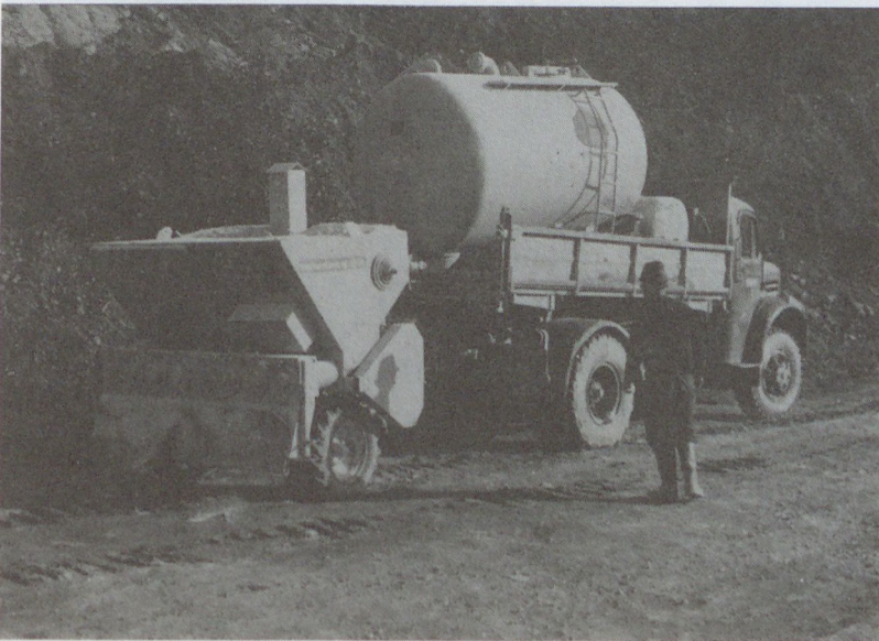
Bild 4.28 Dieses Kalkverteilungsprinzip hat sich beim Bau gut bewährt. Das Verteilergerät wird dem Silofahrzeug direkt angehängt, wobei der Kalk kontinuierlich vom Silo in das Verteilergerät gepumpt wird
