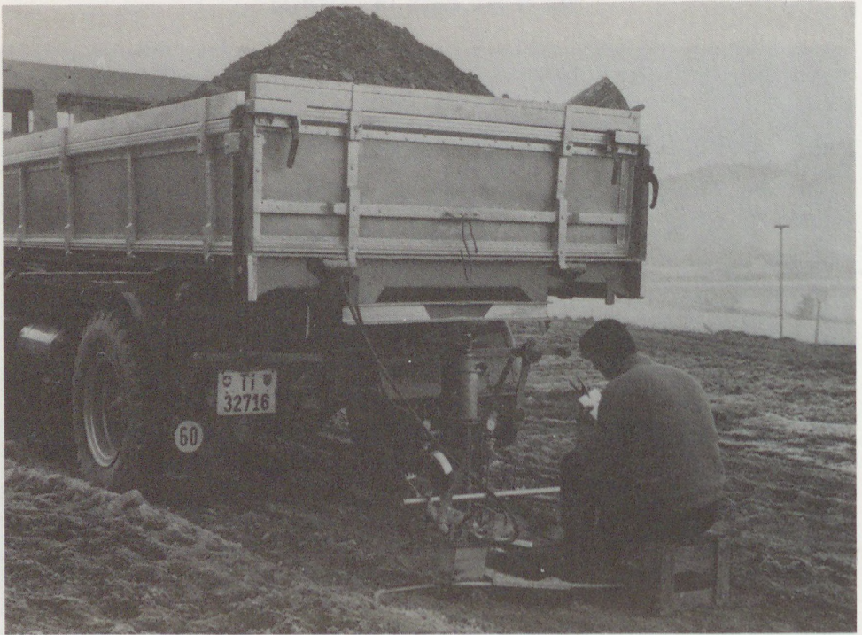
Bild 3.15 Der Verdichtungsgrad ( M_E -Wert) eines Erddammes wird mit dem Plattenversuch kontrolliert
