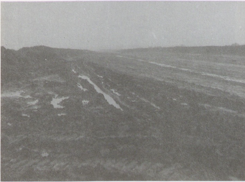
Bild 4.23 Eine Baustelle nach einer längeren Regenperiode. Dieser Boden, der nur mit einer 1 m starken Kiesschüttung saniert werden konnte, wird mittels Bodenstabilisierung mit Kalk ( \text{CaO} ) sofort befahrbar und tragfähig (Aufnahme: Dr. Speck)
