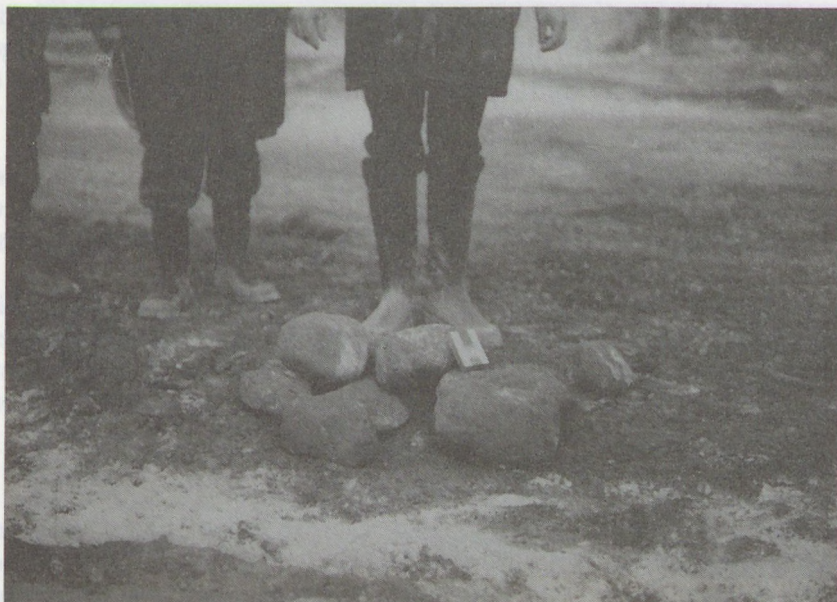
Bild 5.25 Beim Ortсмischverfahren wird die erste Arbeitsphase die Vorbereitung des Bodens sein. Große Steine müssen durch Auslesen oder Zertrümmern eliminiert werden. Schweizer Nationalstraße Nr. 2, Lamone—Chiasso (Photo: Boros)
