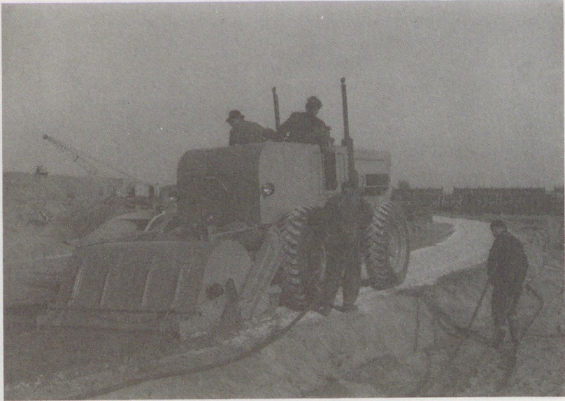
Bild 5.30 Korrigieren des Wassergehaltes bei der Bodenstabilisierung mit Zement. Statt mit dem Wasserwagen oder einfach willkürlich mit dem Hydrantenschlauch Wasser zu spritzen, sollten die notwendigen Wassermengen während der Einmischung beigegeben werden. Auf diese Weise wird eine gleichmäßige Verteilung des Wassers gewährleistet. Das Bild zeigt eine Sandverfestigung mit Zement in Holland (Photo: Dr. Speck)
