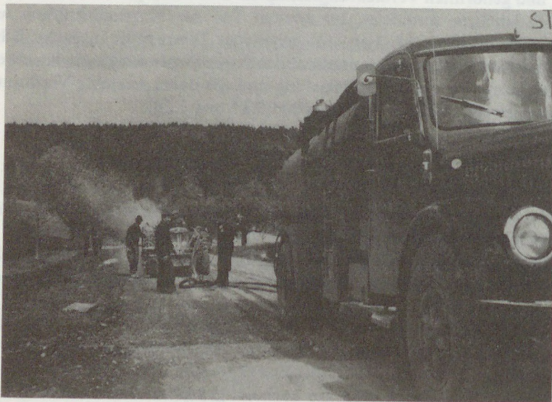
Bild 7.22 Stabilisierung der Oberfläche einer bestehenden Straße mit Heißteer. Die Straße wurde zuerst aufgerissen und bis zur gewünschten Tiefe aufgelockert. Dann wird sie mit einer Bodenfräse unter gleichzeitiger Zugabe von Heißteer (Spritzbalken), der vom Tankwagen direkt zugeleitet wird, durchgemischt. Nach anschließender Verdichtung erhält man mit einem bescheidenen Kostenaufwand eine glatte, tragfähige und staubfreie Straßenfahrbahn (Photo: Shell)
