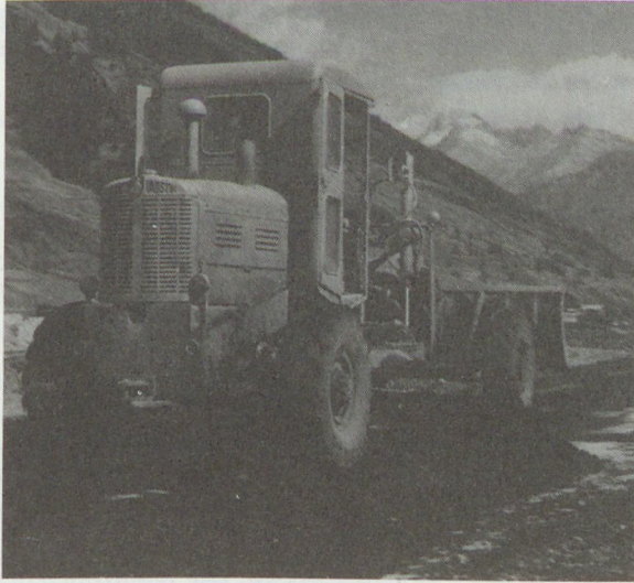
Bild 7.23 Auf rasche und einfache Weise wird hier mit dem Bitumen-Stabilisierungsverfahren ein Militärflugplatz in der Schweiz gebaut. Unsortierter Wandkies wurde in einer Mischanlage (Zentralmischverfahren) mit heißem Verschnittbitumen gemischt. Das Mischgut wurde mit Lastwagen auf die vorbereitete Ebene gekippt und in zwei Schichten mit einem Grader verteilt, anschließend mit Walzen verdichtet. Während des Transportes und dem Verteilen verflüchtigen sich die Verschnittöle aus dem heißen Mischgut; beim Verdichten ist die Mischung gebunden, tragfähig und fest
