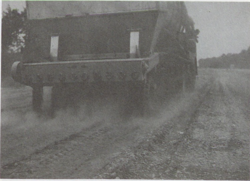
Bild 5.28 Verteilung des Zementes beim Ortsmischverfahren. Zementsilo auf Lastwagen, dahinter Verteilergerät (Photo: Betonstrassen AG, Wildegg)
