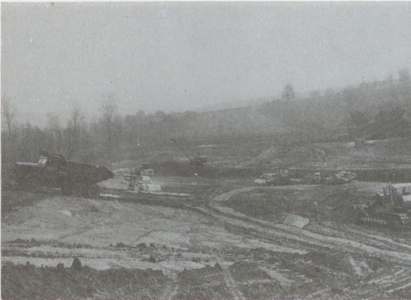
Bild 4.24 Die Großbaustelle eines Autobahndreieckes in Deutschland. Nasser, breiiger Lößlehm, dessen Verwendung ohne Stabilisierung mit Kalk undenkbar wäre. Hier sind 7 Stabilisierungszüge bei der Arbeit (Aufnahme: Dr. Speck)
