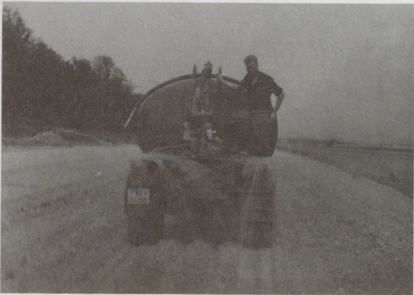
Bild 5.27 Ortsmischverfahren: Wasserzugabe (Photo: Betonstrassen AG, Wildegg)
