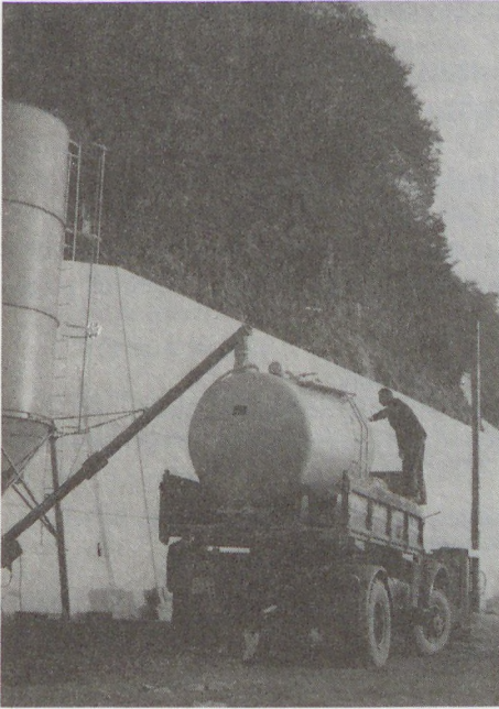
Bild 4.16 Vom stationären Silo aus wird der lose Kalk schnell (rationell) und gefahrlos mit der Förderschnecke in das Aufsatzsilo befördert. Der Lastwagen mit dem Aufsatzsilo pendelt zwischen dem stationären und dem Verteilerfahrzeug. Auf diese Weise kann eine ununterbrochene Kalkverteilung auf der Baustelle gewährleistet werden
