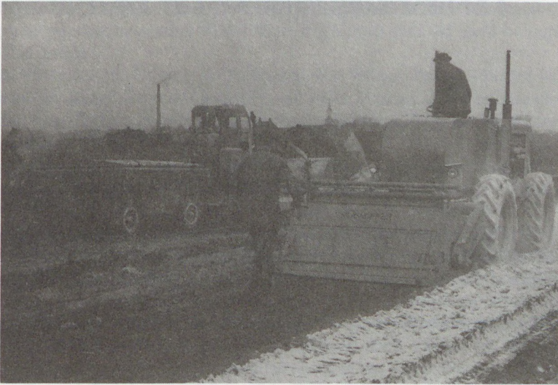
Bild 4.35 Die Einmischung des Kalkes in den Boden mit einer Bodenfräse (Aufnahme: Dr. Speck)
