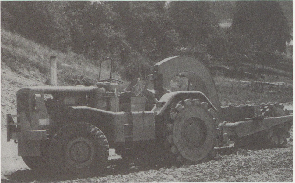
Bild 3.14 Tampingwalze. Von ähnlichen Verdichtungsgeräten mit Vibration erhofft man einen besseren Verdichtungseffekt (Aufnahme: Kt. Zürich, Tiefbauamt)
