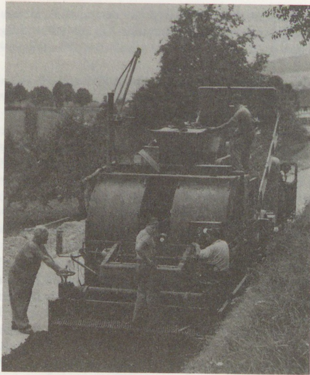
Bild 7.21 Stabilisierung eines Wandkieses mit Verschnittbitumen. Der nicht vorgewärmte Wandkies wird direkt vom Lastwagen in den Straßenfestiger gekippt, wo das vorgewärmte Verschnittbitumen dosiert und mit dem Wandkies gemischt wird. Die Mischung wird auf der Straße ausgebreitet (Photo: Shell)
