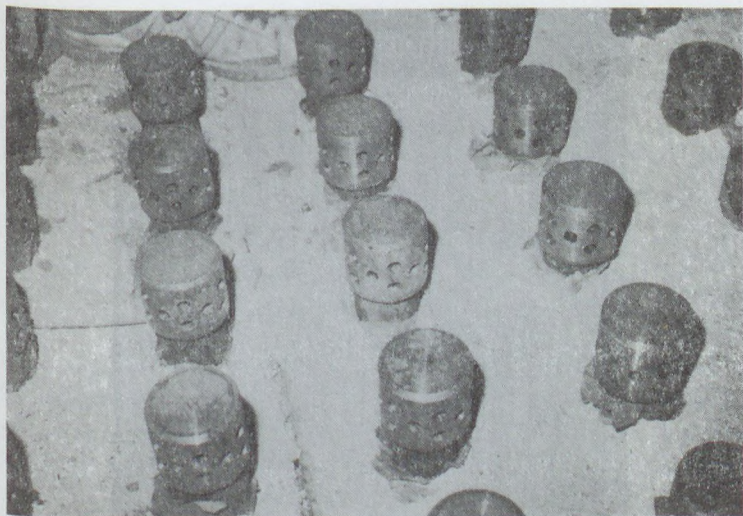
3.27. ábra. Az Ajkai Erőmű kazánjainál a levegőfúvóka-rendszer megoldása
