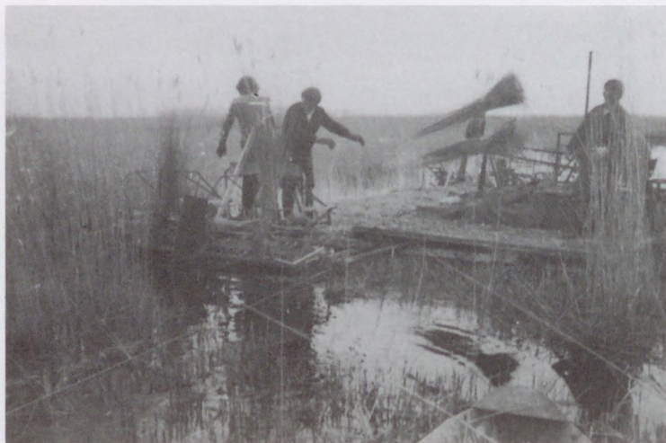
14. ábra. Önesörlős úszó nádarató
