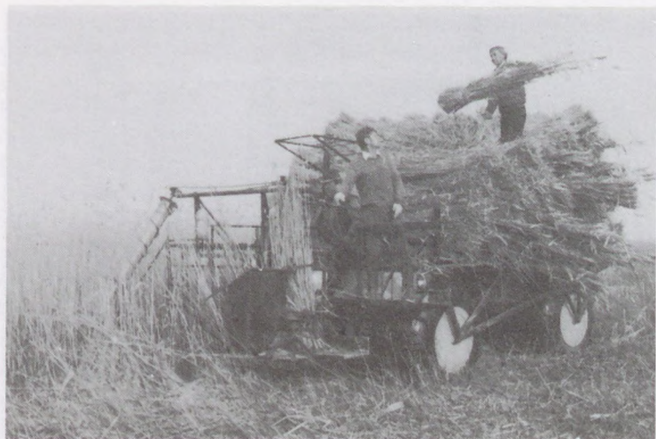
9. ábra. HNB-1200 típusú nádarató gép
