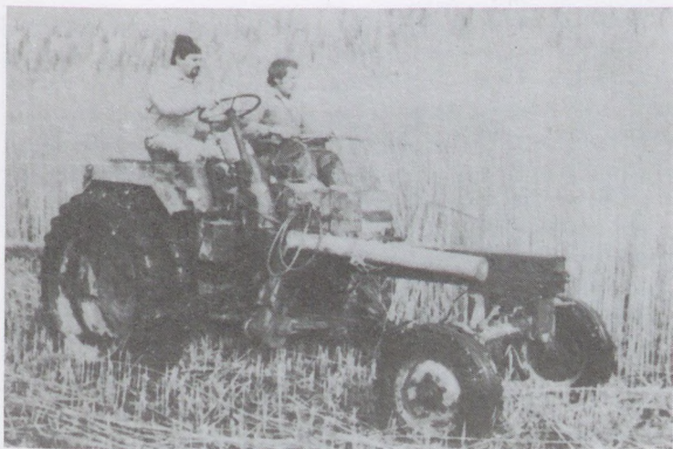
6. ábra. RS—9 típusú traktoros nádvágo (MGI, 1961)
