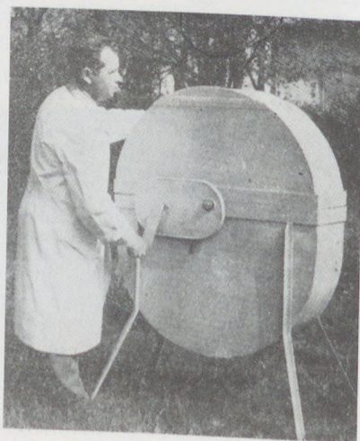
28/d. Motoros és kézi meghajtású, 28 nagykeretes dobpergető
