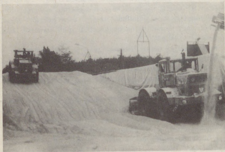
2. ábra. Terítés és tömörítés K-701 traktorokkal
