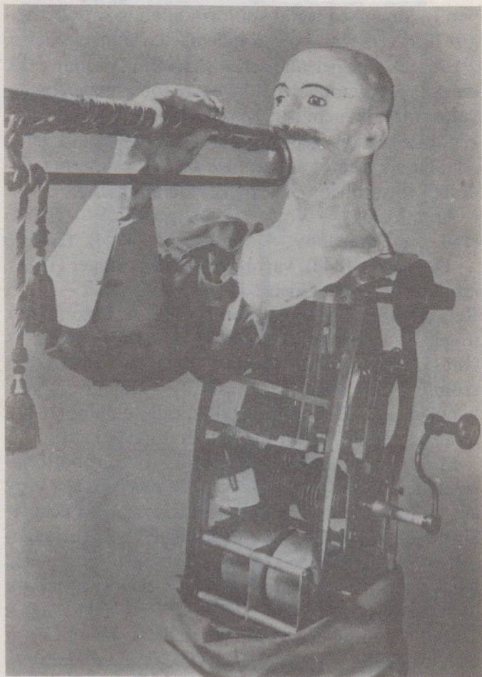
13. ábra: Friedrich Kaufmann 1810-ből származó trombitáló androidja (Swoboda, H. i. m.)
