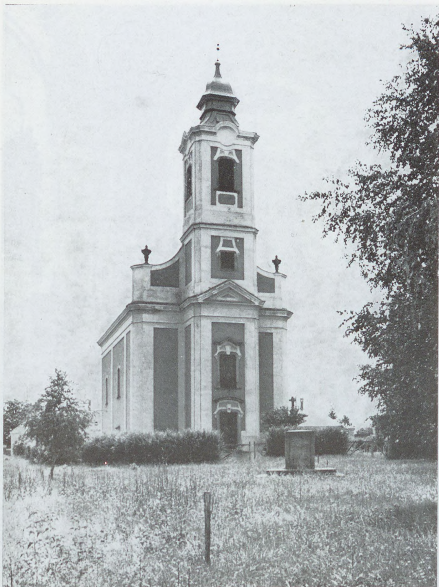
62. Pápateszér, r. k. templom főhomlokzata
