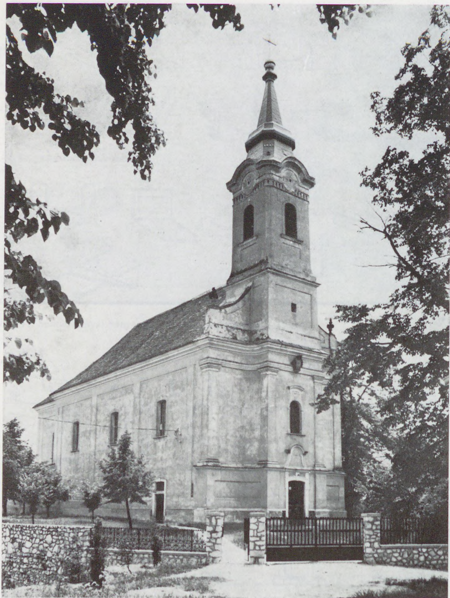
49. Ugod, r. k. templom főhomlokzata
