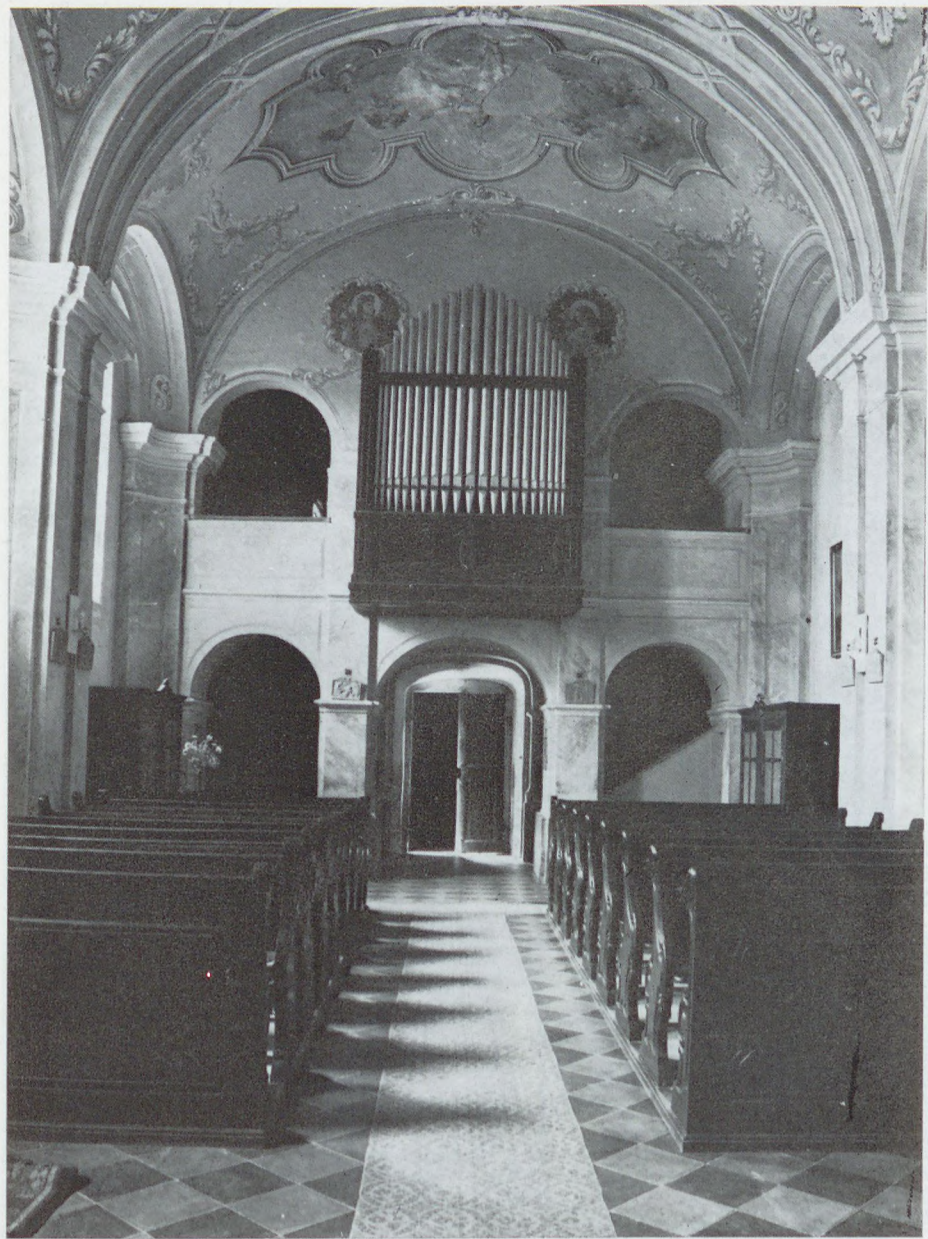
41. Nyárad, r. k. templom „czirádákkal”, stukkótükrökkel és a toronyépítéskor kialakított árkádos orgonakarzattal
