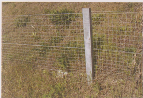
60. ábra. Nagy lyukbőségű kételtű terelő az M3-as mentén. A fiatal állatok átjutnak a kerítésen és az úton elpusztulnak (Fotó: dr. Puky Miklós)
