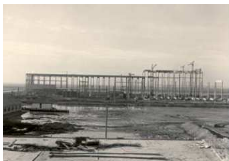
A TVK Műtrágyagyár építése (1961)
