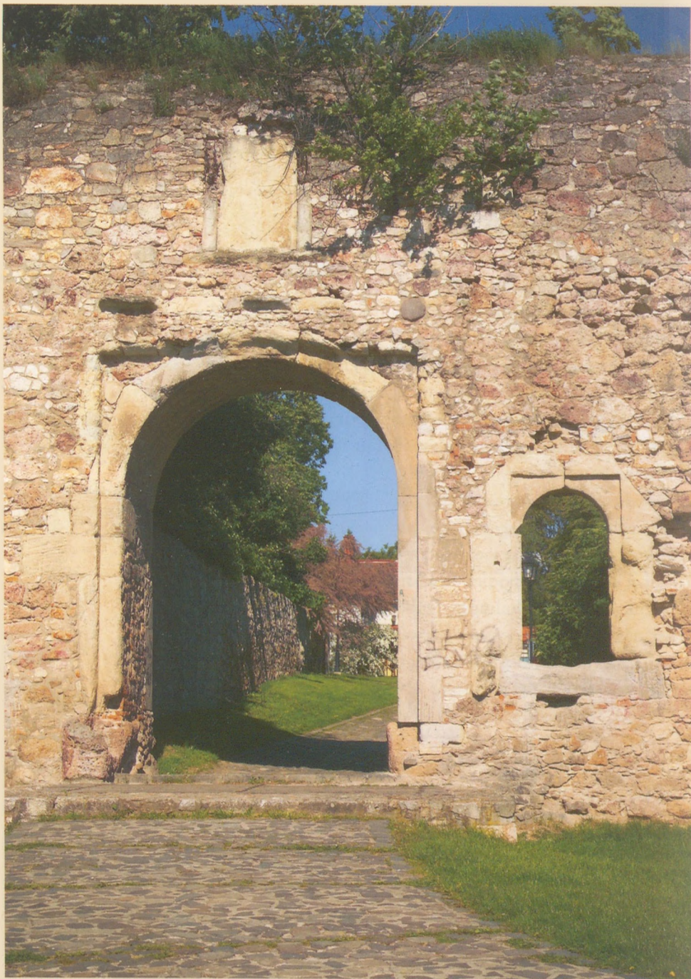
A sárospataki vár Bodrog felőli bejárata: a Vízi-kapu és a lepusztult építési tábla. Felirata egykor a külső vár építkezésének lezárását örökítette meg: „Boldog az a város, melyben Isten ígését hirdetik és megtartják. 1541. április 17.”
