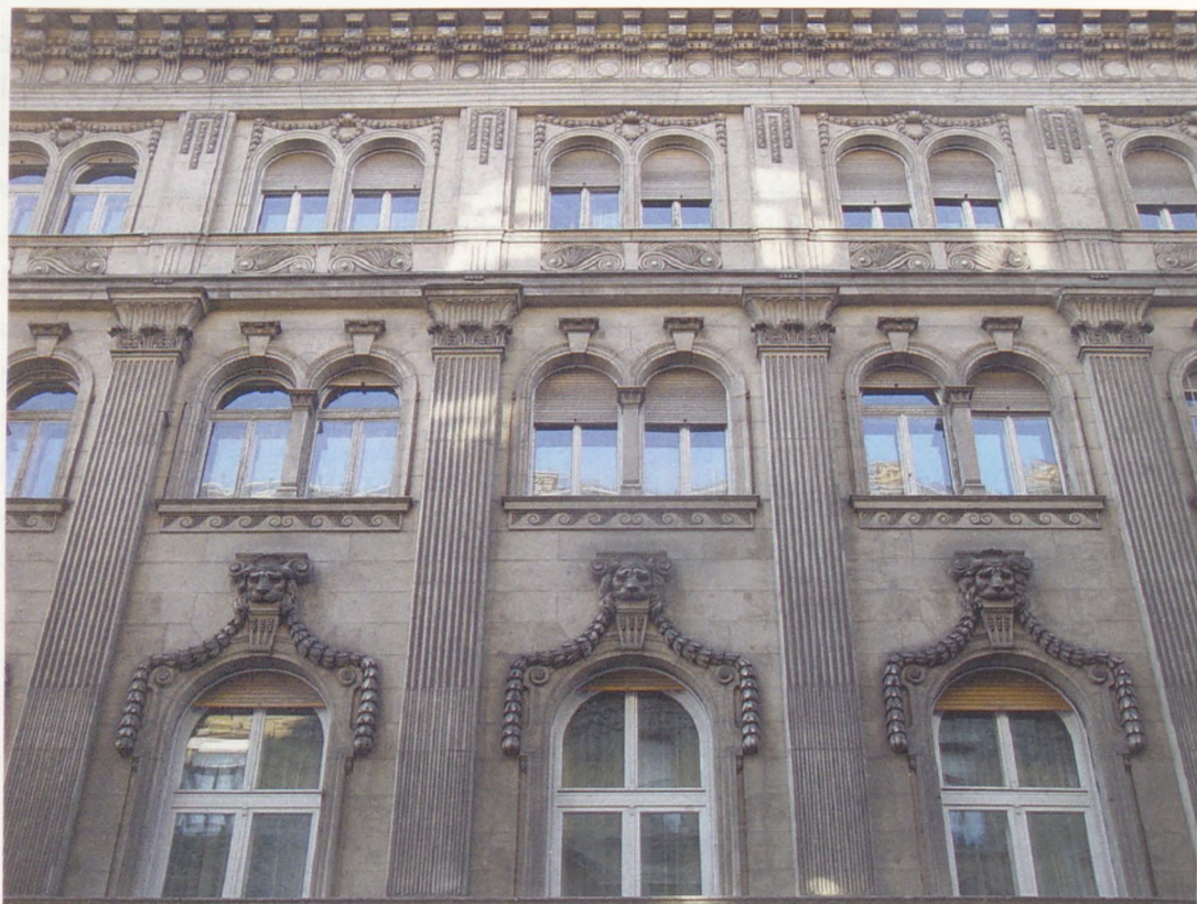
A KÜLKERESKEDELMI MINISZTERIUM MŰEMLÉKI SAROKÉPÜLETE – A VOLT KERESKEDELMI KAMARA SZÉKHÁZA, BUDAPEST
