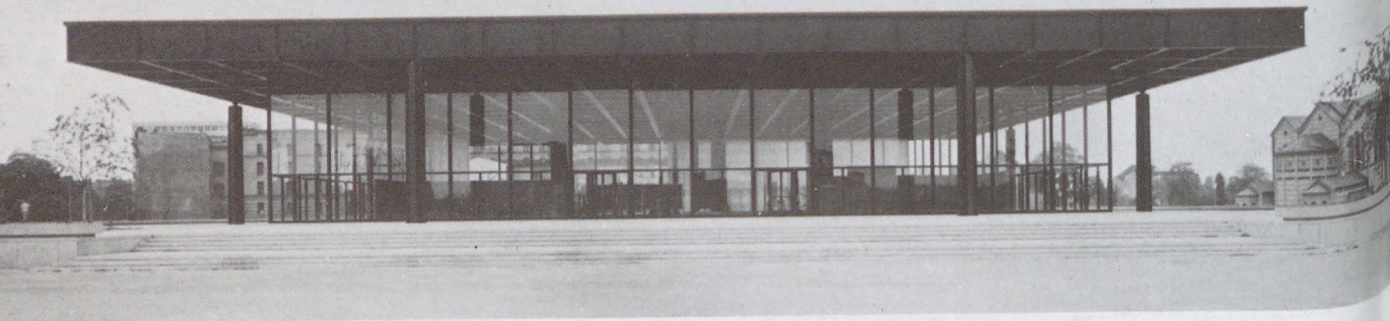
60 Widok od strony głównego wejścia
