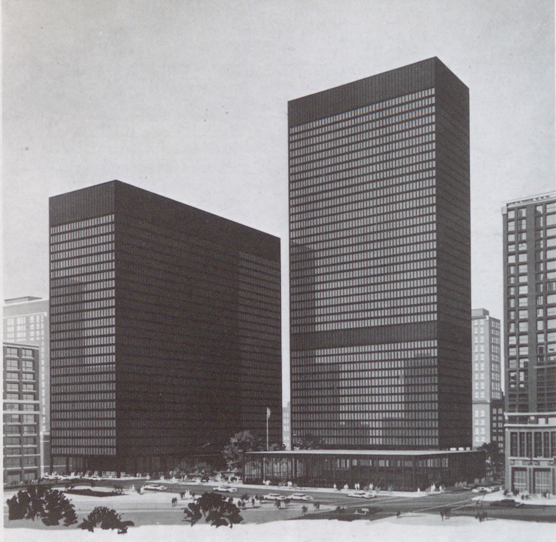
67 Budynek Sądu Stanów Zjednoczonych i Urzędu Federalnego, widok od strony głównego wejścia
