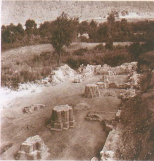
129. ábra. Pilisszentkereszt, templom, pillérsor
