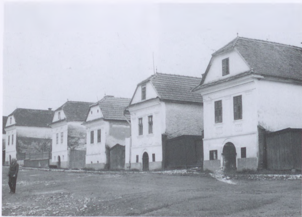
177. Uteakép típusos lakóházakkal. Torockó (Torda-Aranyos vm.)
