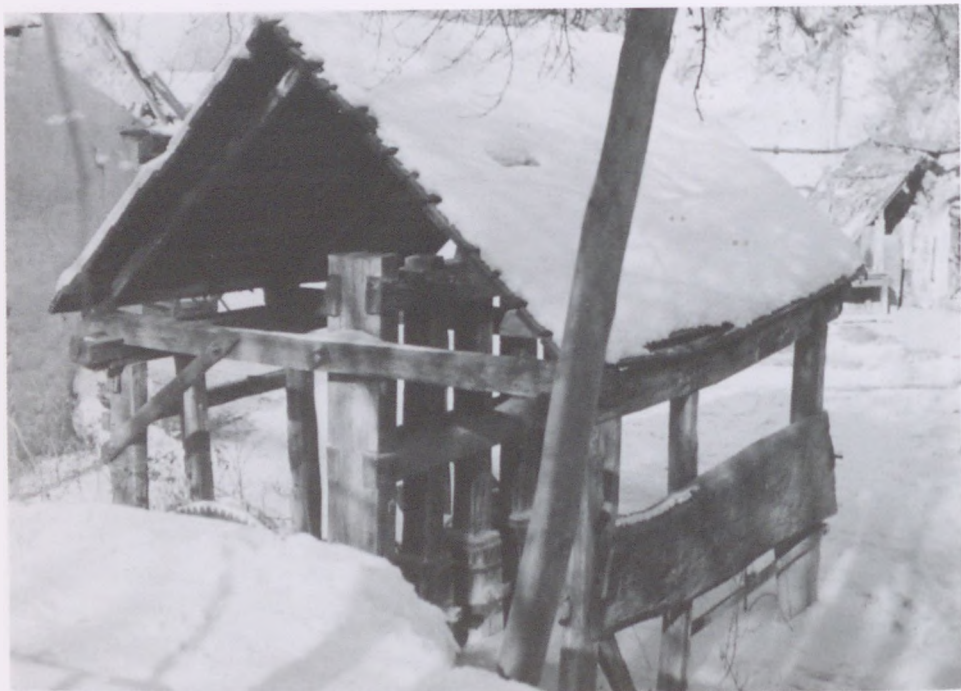
160. Kendertörő bakó (törőmalom). Szilvásvár (Borsod vm.)
