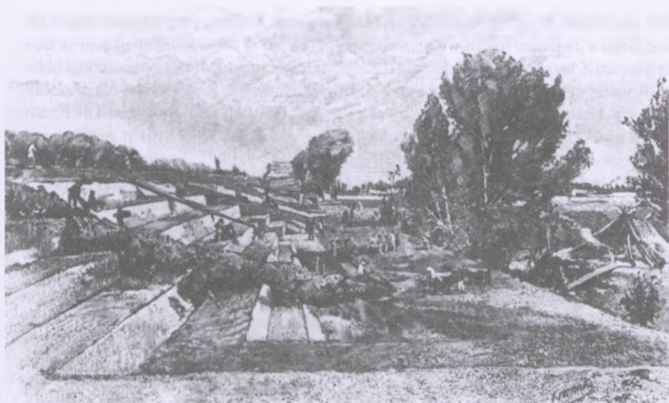
10. ábra. Árvízi töltés építése az 1880-as években
