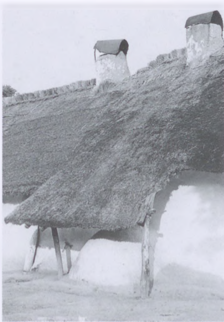
116. Falon túlnyúló kemence és tapasztott sövénykémények. Tápszentmiklós (Győr vm.)
