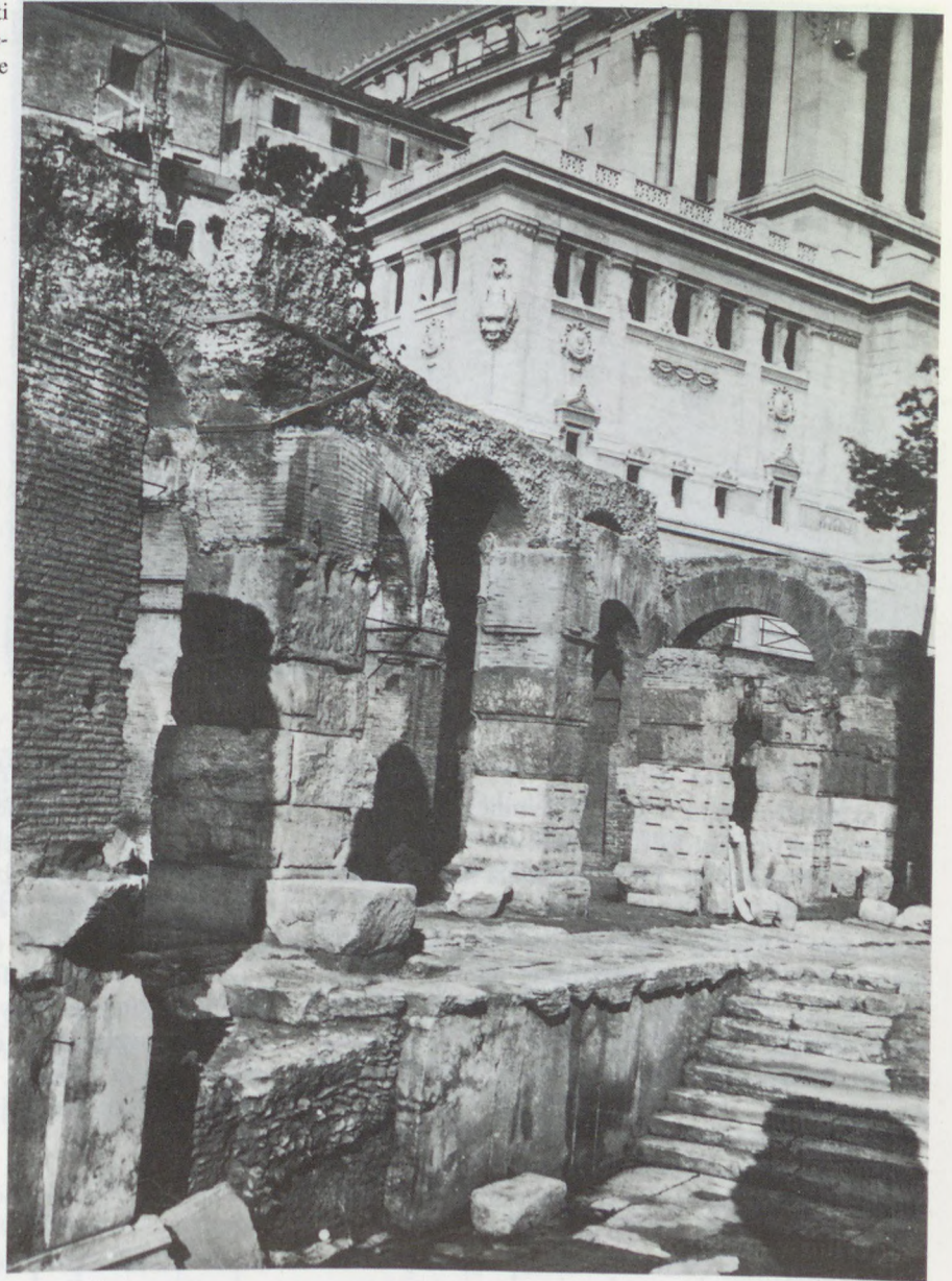
186. Basilica Argentaria. Keleti pillérsor, alul travertin-, felül peperinotömbök, elől a diadalív pillére és a Basilicához vezető lépcső
