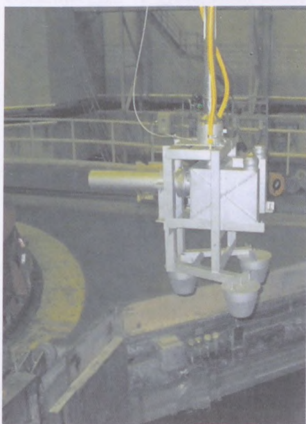
42. ábra: A berendezés beemelése a pihentető medencébe
