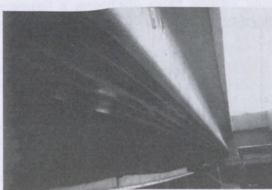
34.61. ábra. A Petőfi-híd Boráros téri feljáróhídjában lévő előfeszített EHGTM tartó megerősítése (1997. szept., megerősítő lemezek: Sika CarboDur M914–56m és M614–84m, tervező: BME Vasbetonszerkezetek Tanszéke: Dr. Balázs L. György és Dr. Farkas György, kivitelező: Pannon Freyssinet Kft.) [Balázs, 1999]
