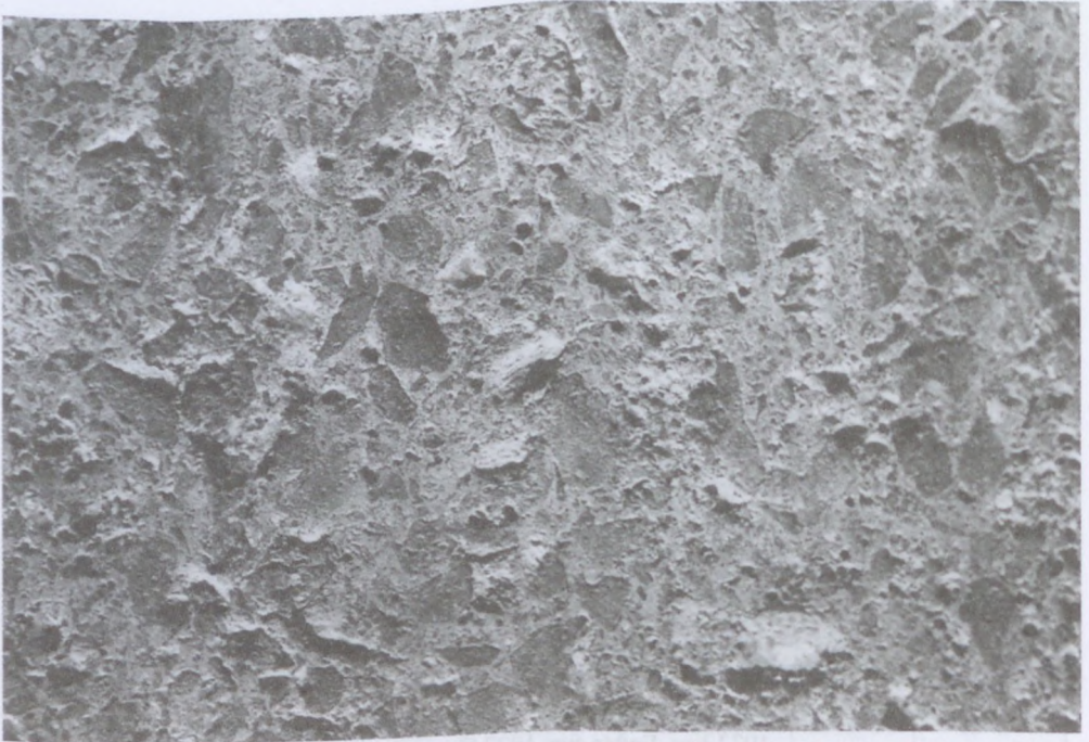
30.2. fénykép. A 10-es út 1927-ben épített betonjának felülete a 48+000 km szelvényben [Liptay (1972)]
