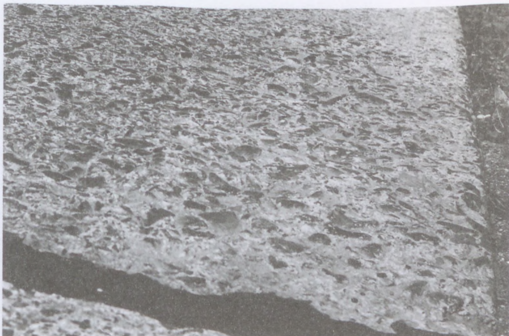
30.10. fénykép. 7-es út 168+100 km szelvényében a felület sérülése. A durva zúzott szemcsék a habarcsból kiállnak
