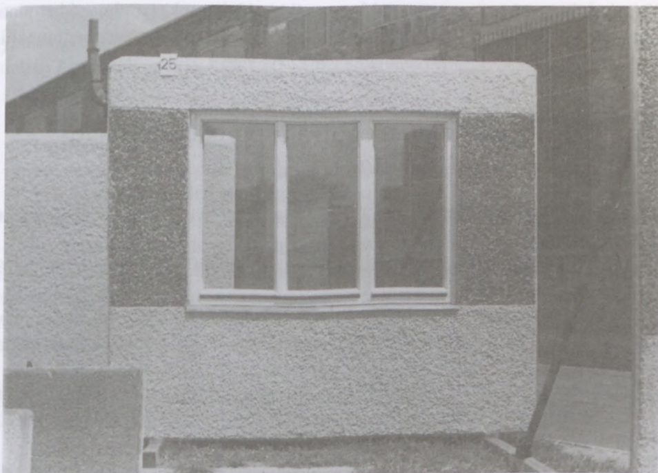
8.5. fénykép. Mosott betonfelület. Parapet és szemöldök leányvári mészkőzúzalékkal, ablakmező zalahalápi bazalttal, a szemcséket normál portlandcement-habarcdba terítették [Kiállítás (1969)].
