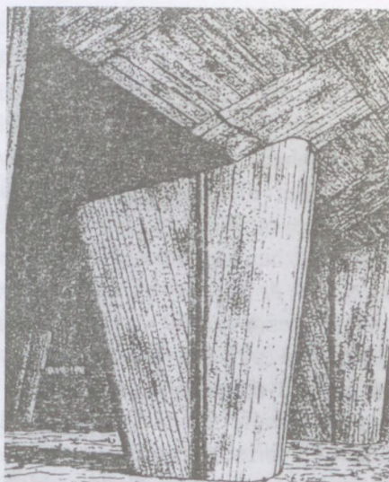
8.5. ábra. Felfelé szélesedő pillér zsaluzása gyalulatlan deszkával. (Armut-Balázs-Ujhelyi, 1967)
