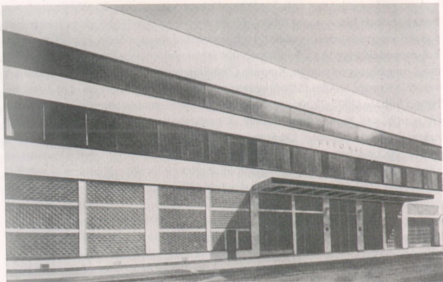
424. Az Üvegház homlokzata. Tervezte: Kozma Lajos, 1935
