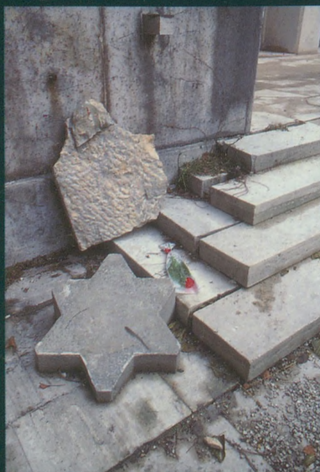
Hősök temploma. A bejárati kapu lépcsője, építkezési munkálatok közben
