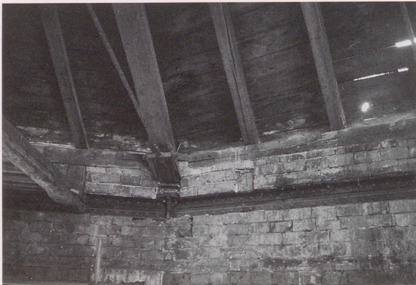
52 Kupolaszerkezet, vas-tartógyűrű a külső falban, fénykép, 1989
