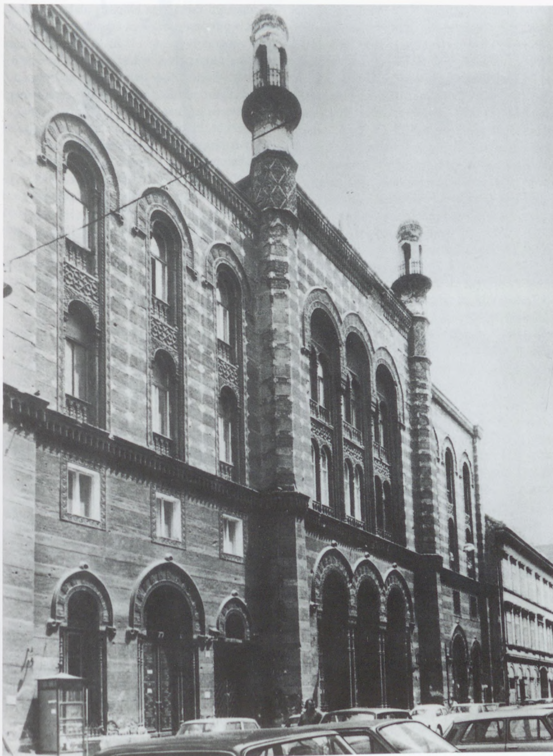
36 A Rumbach utca felé néző homlokzat, fénykép, 1985 körül
