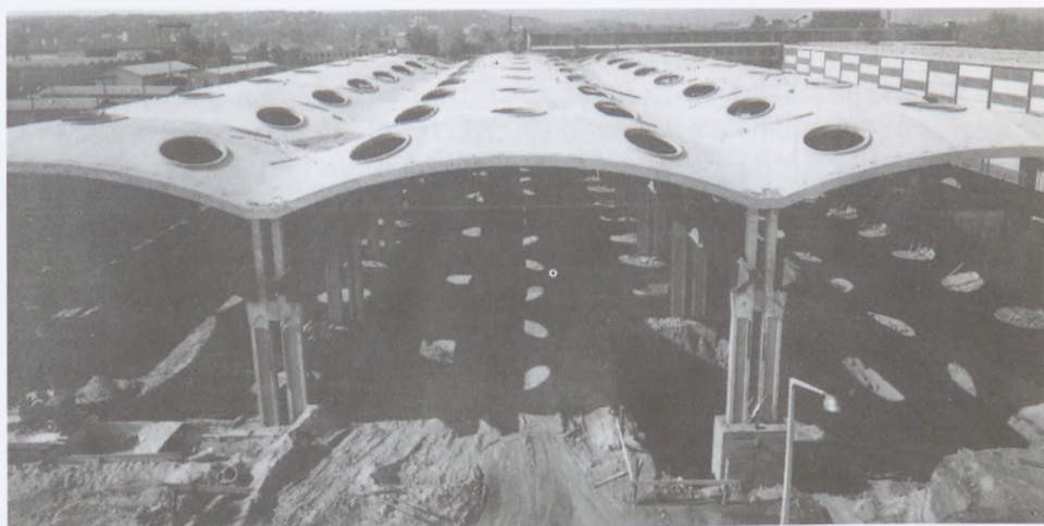
15.142. ábra. A Csepeli Szerszámgépgyár csarnoka: a) alaprajz, metszet, oldalnézet; b) a megépített csarnok [Reisch R. (1972)] (Fotó: Bognár János)
