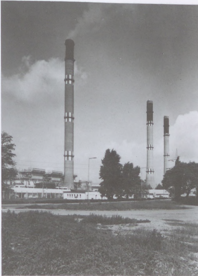
15.85. ábra. A Dunamenti Hőerőmű három kéménye (Fotó: Gyenge Csilla)
