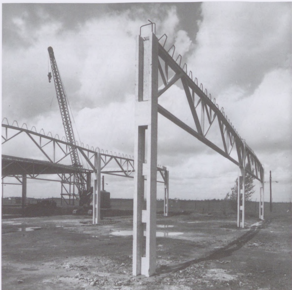
15.39. ábra. Példák az SR jelű vázszerkezet alkalmazására. a) KGM 9×12 m-es típuscsarnoka, 1965. Szerkezettervező: Reisch Róbert (Fotó: Bognár János) b) KGM 12×18 m-es típuscsarnoka, 1964;
