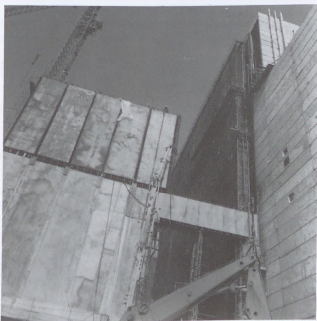
15.119. ábra. Paksi Atomerőmű. Építés kéregzsálaban: a) szerelés közbeni állapot; b) elhelyezett kéregzsálab (Fotó: Deák Hunor)
