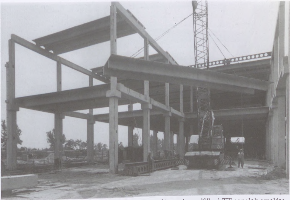
15.62. ábra. Gyulai Húskombinát a) üzemépület; b) „oszloperdő”; c) TT-panelok emelése (Fotó: Gyenge Csilla)
