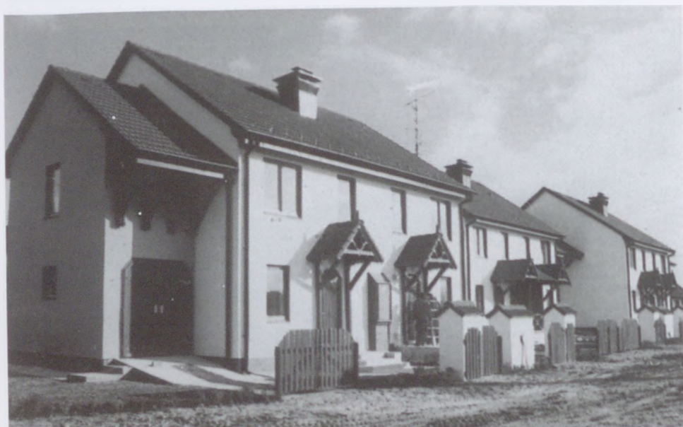
14.19. ábra. Továbbfejlesztett rendszerek. a) a „HÁZ-VÁZ” rendszer csomópontjai (vázlatok) [Andor B. (1990)]; b) LMS rendszer, építéshelyi „máglyázott” előregyártás; c) szerkezetszerelés, háttérben a megépített sorház; d) Győr, Ergényi úti lakótelep 6 lakásos láncháza, ROPS M30 szerkezetből (Gyártmányismertető)
