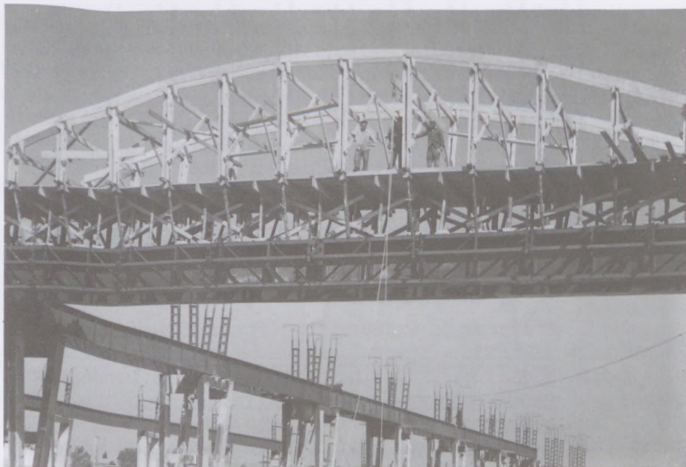
15.6. ábra. Faszkerzetű, sínen gördülő zsaluzat a héjak készítéséhez [Farkas I.–Menyhárd I. (1960)]
