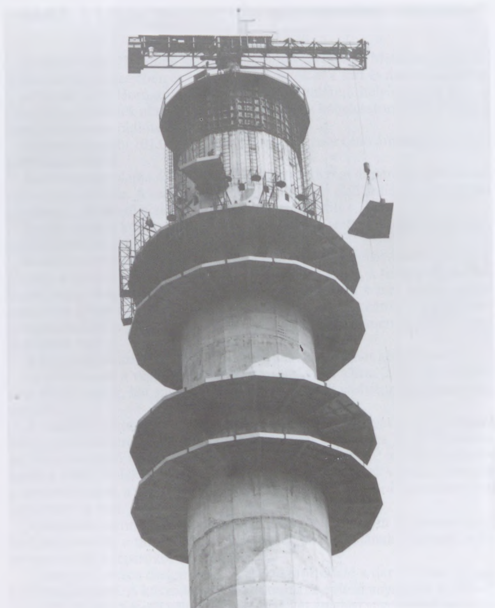
16.112. ábra. A kiskunfélegyházi adótorony erkélyeinek építése [Reiner E. (1980)]
