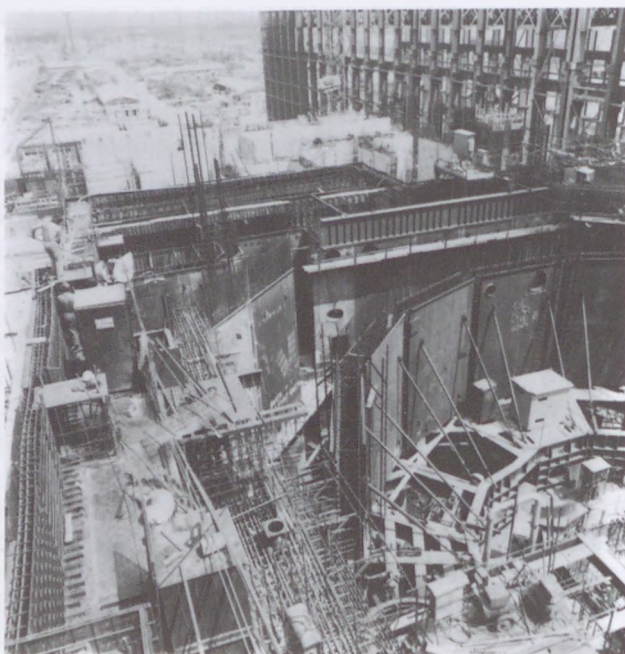
15.117. ábra. Paksi Atomerőmű. Főépület: a) reaktortér vasszerelése; b) reaktortér építése. Mindkettőn látható az acéllás zsaluzat (Fotó: Deák Hunor)
