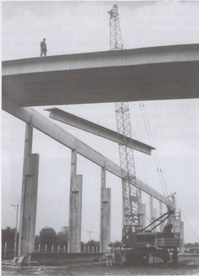
15.60. ábra. Orosházi Síküveggyár: a) 12×18 m-es, TT-panel lefedésű csarnok; b) T födémpanelek beemelése (Fotó: Gyenge Csilla)
