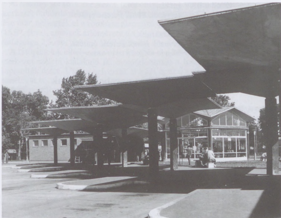
16.90. ábra. Egy ponton alátámasztott perontető a ) héjszerkezete [Varga Á. (1967)]. Jelölés: 1 – emelőkampó és lombkosár utólag felhegesztve; 2 – előre gyártott héjelem; 3 – bekötőkarom; 4 – diafragma; 5 – acéllemez karima; 6 – előre gyártott pillér; 7 – utólagos hegesztés; 8 – L 50.50.7; 9 – pilléracélbetét; 10 – kengyel; 11 – vasbetonhéj alsó és felső töréspontja. b ) A szekszárdi buszpályaudvar perontetője (Fotó: UVATERV fotólaboratóriuma, Löbñé Szidon Mária)
