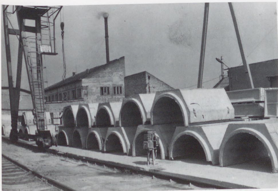
6.23. ábra. MIRABET csövek a BVM Miskolci Gyárában. a) A csövek gyártása fazsaluban; b) legyártott csövelemek a gyárudvaron (Fotó: Nagy Árpád)
