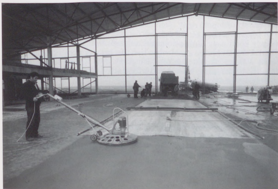
5.39. ábra. Csarnoképület betonburkolatának építése vákuumozással a Ferihegyi repülőtéren: a) a beton bedolgozása felületi vibrátorral; b) a sárga színű szűrőszövet és a kék színű vákuumpaplan létesítése; c) felületsimítás (Varga László felvétele, BUV)
