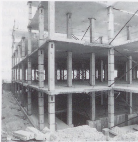
6.51. ábra. Lift-slab technológia. a) Emelőkeretek; b) emelősajtó; c) példa a megépített oszlop-födém rendszerre (Fotó: 22. sz. ÁÉV , Deák Hunor )
