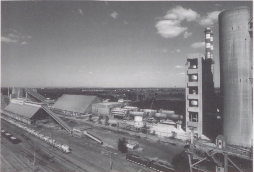
2.6. ábra. A Hejőcsabai Cementgyár távlati képe jól szemlélteti a gyártási folyamatot (jobbról balra haladva)
