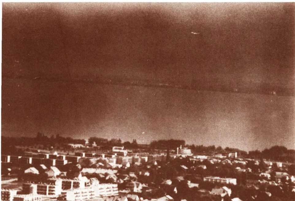
Kisfaludy-üdülőtelep távlati képe. Part felé eső végén a Paksi Atomerőmű kör alakú üdülője, mellette az ÉGSZI-üdülő épületegyüttese. (1986.)
