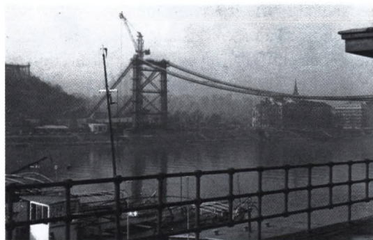
...a pilonok már álltak és a kábelek fent voltak
