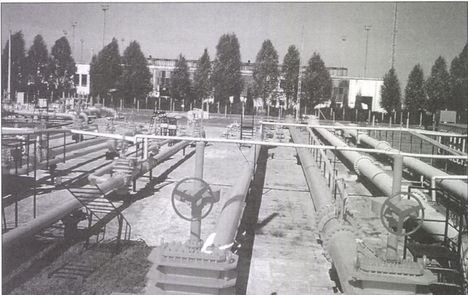
29. ábra. Gázmérő, illetve -kiadó állomás
