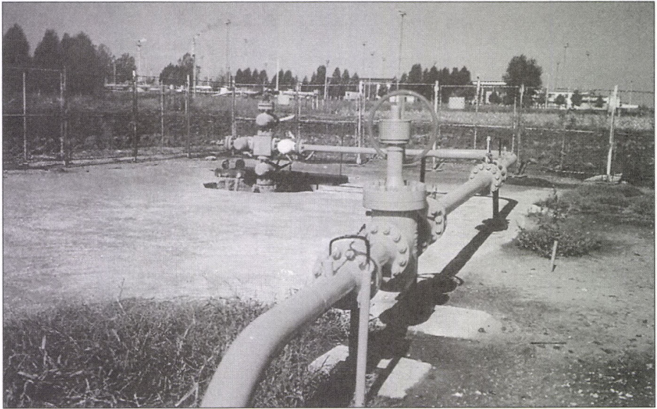
24. ábra. Tipikus gáztermelő, illetve -besajtoló kút
