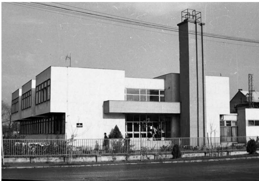
10. kép A 126. Sz. Szakmunkásképző Iskola épülete
