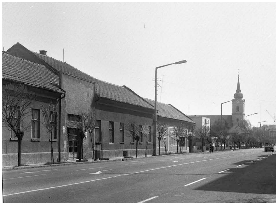
23. kép A Berettyóújfalui Állami Gimnázium épülete (később Tanácsháza)
