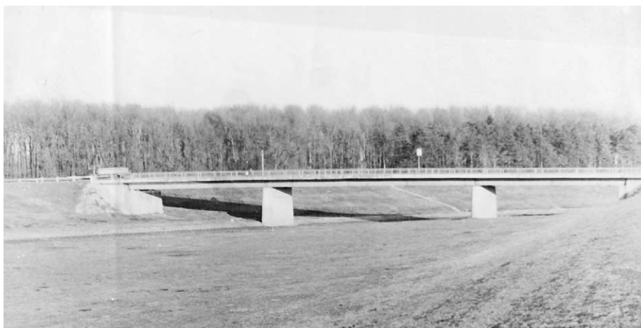
21. kép A Berettyóújfalut Berettyószentmártonnal összekötő, ma is használatban lévő új vasbeton híd
