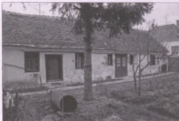
45. kép. A ház az udvar felől: a kamra ablaka alatt egy, az eresz alatt tárolt hargun (vizesvödörhúzó rúdon) lógó vödör látszik, 2002.
