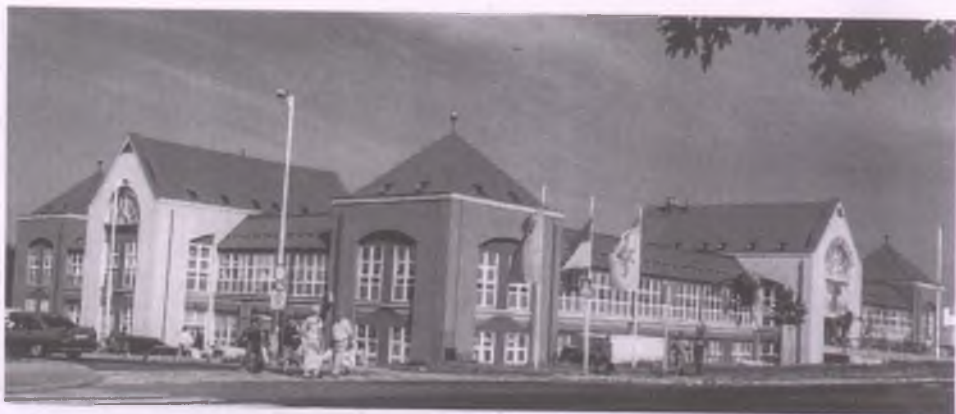
36. kép. Az 1997-ben épült modern vásárcsarnok.
