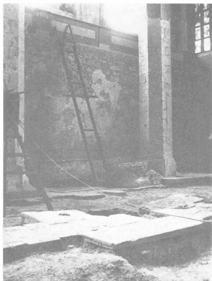
8. A főhajó és az északi mellékhajó részlete a járószintre helyezett sírkövekkel
