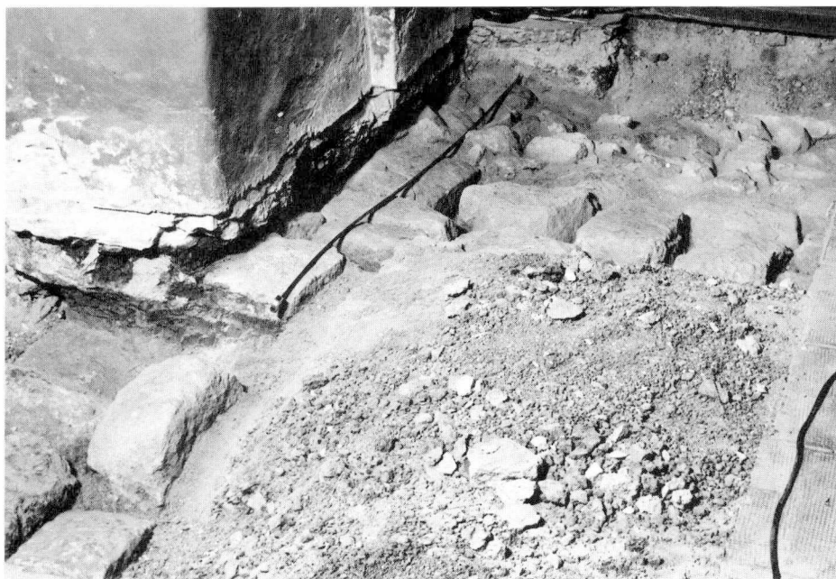
11. A kétféle alapozás délnyugati sarka
