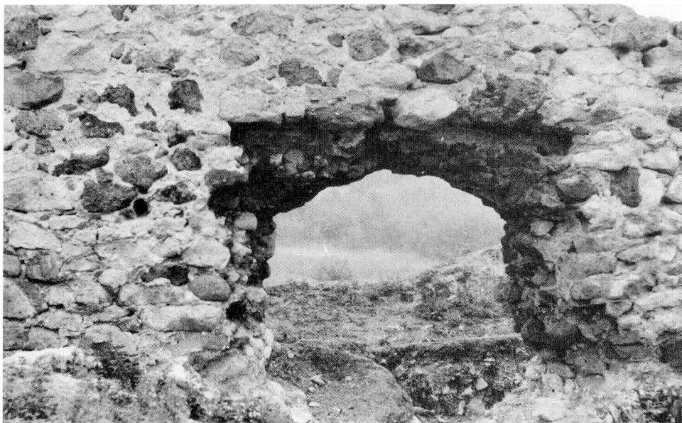
166. Az 1. sz. földszinti helyiség ablaknyílása (a Ny-i falban) a külső felől
