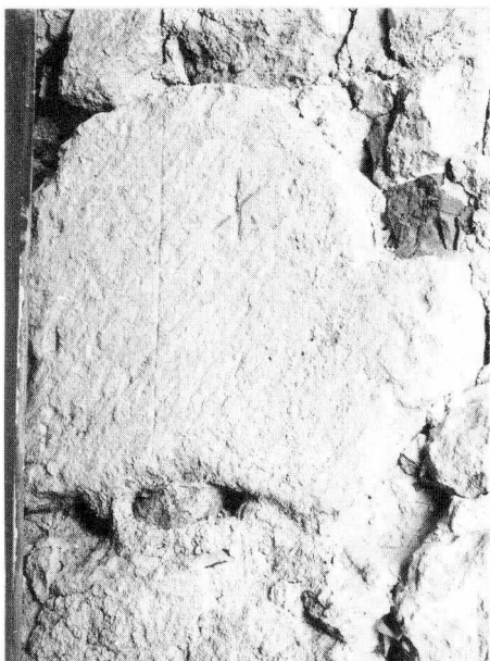
49. Az átépített nyugati hajófalba másodlagosan beépített faloszlop rétegekőve
