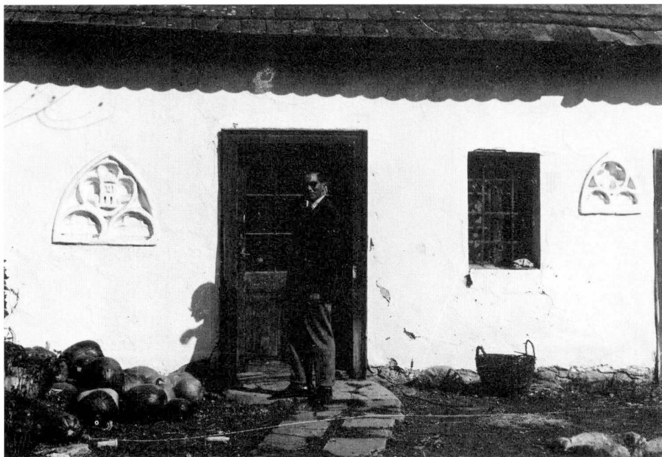
24. A plébánia gazdasági épületének falában másodlagosan elhelyezett — a karéjok és a szentély ablakaiból kiemelt — mérművek
