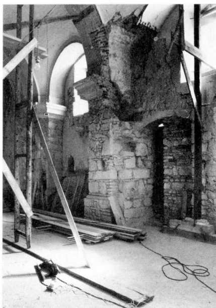
52. A kibontott gótikus kapuzat belső áthidalása és a felette lévő konzol
