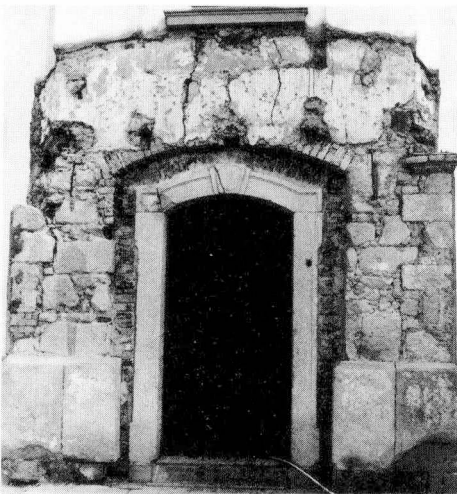
32. A barokk torony nyugati homlokzata helyreállítás közben (a lebontott „porticus” visszahelyezése előtt)
