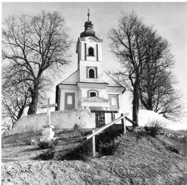
130. A templom helyreállított főhomlokzata az új feljárattal
