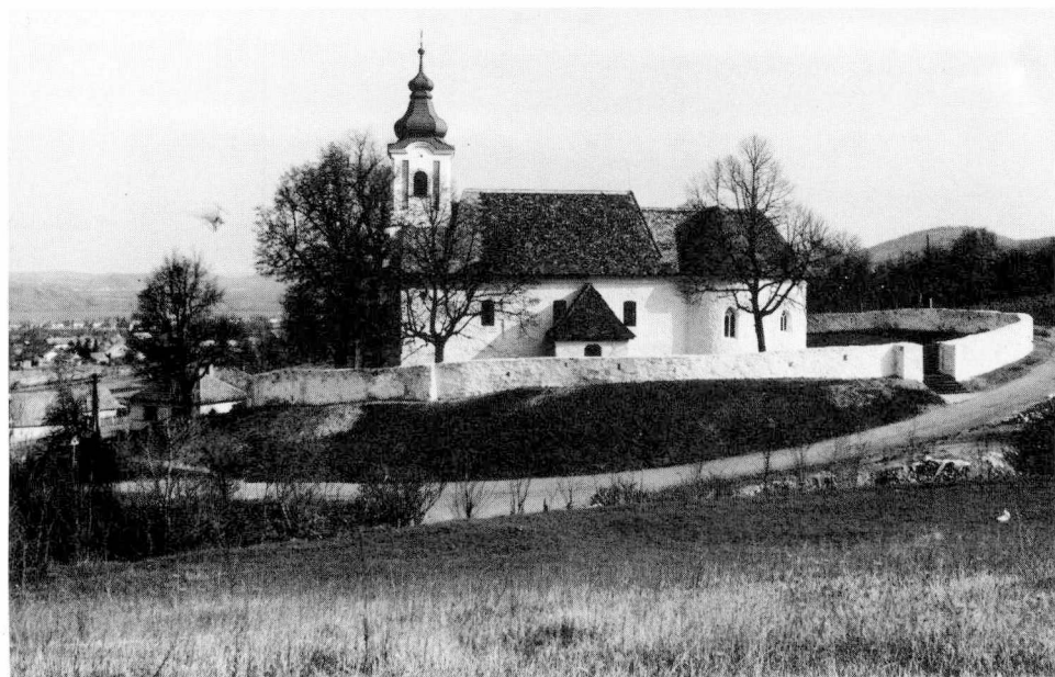
88. A helyreállított templom dél felől
