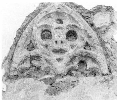
26. A gazdasági épület falából kibontott mérmű
