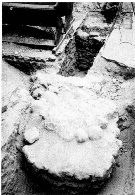
13. A nagyméretű — a hajó hossz tengelyében húzódó — oszlopalapozás
