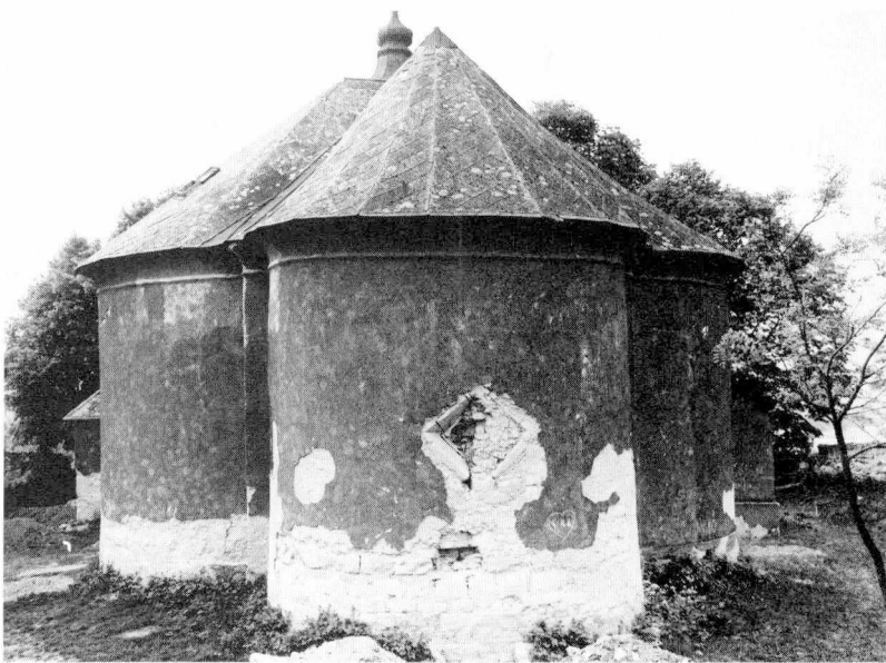
6. A templom keleti homlokzata a kutatás megkezdésekor
