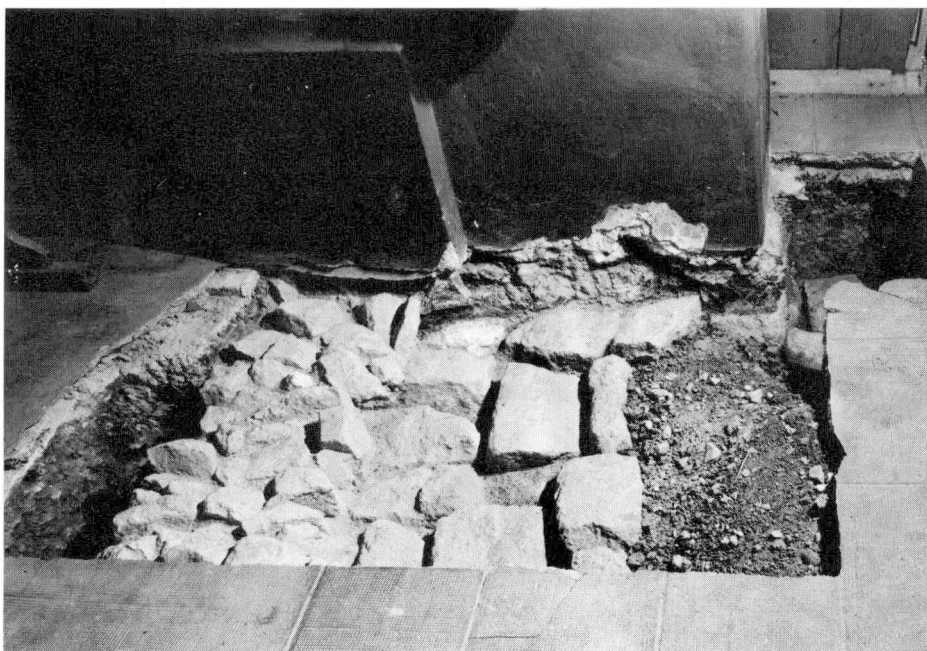
10. A szárazon és a habaresba rakott kőalapozások a feltárás után
