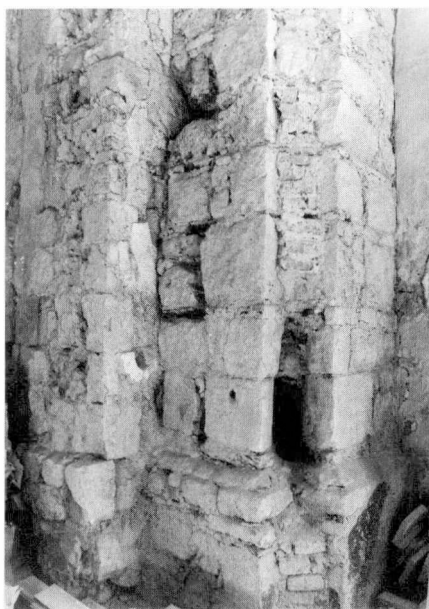
51. A hajó DK-i sarkában álló barokk pillér, a másodlagosan beépített oszlopdobokkal
