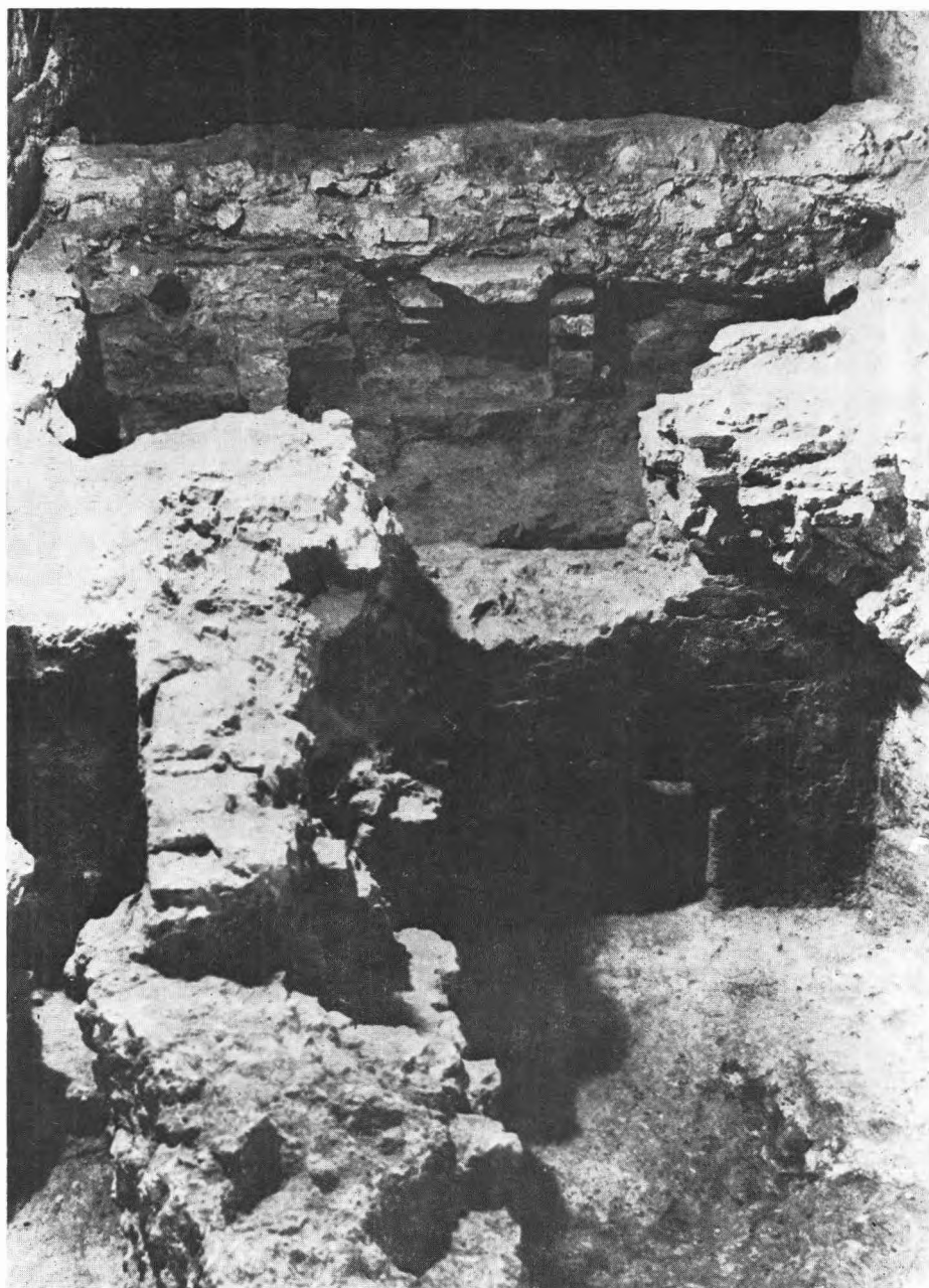
100. Buda. Pasapalota. A fürdő fűtőberendezése, a fűtőkamra a kemence tüzelőnyílásával
