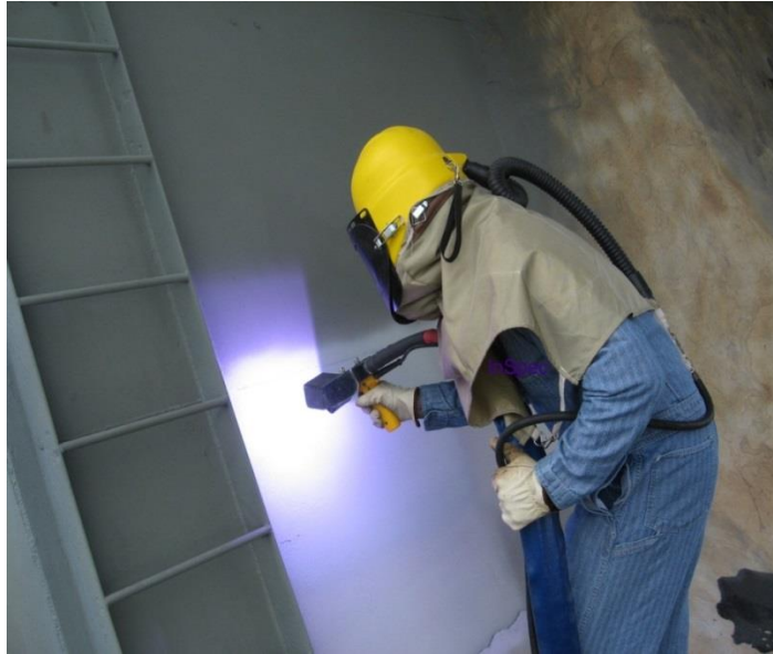
3. ábra. A villamos ívszórás gyakorlati kivitelezése
