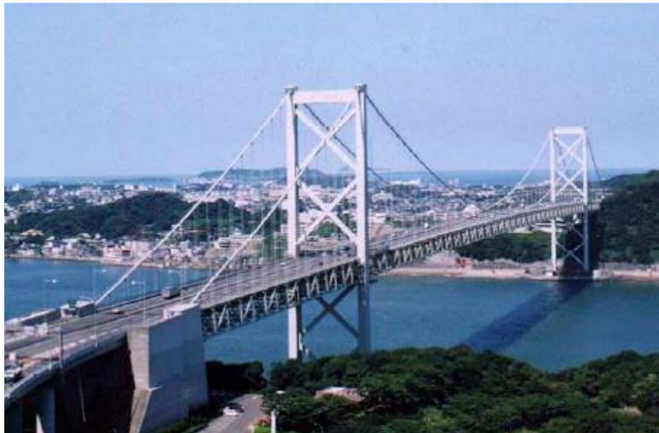
8. ábra. Az 1973. évben épült Kanmon híd – amelynek acélszerkezetét termikus szórással felvitt Zn réteggel és 6 rétegű festéssel látták el a korróziótól való védelem céljából
