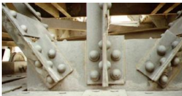
11. ábra. A kanadai Saint Andrew híd Zn-el felszört része és festés után
