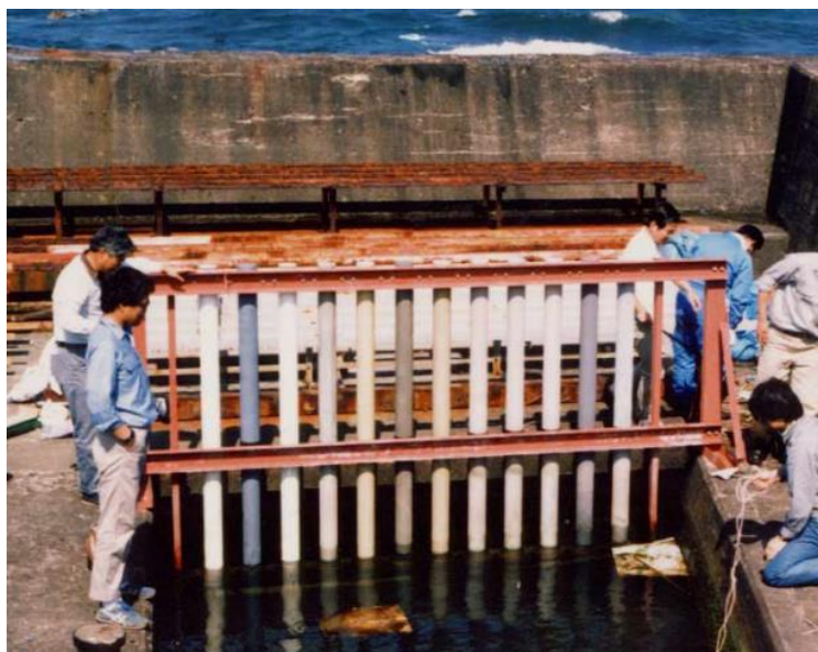
8. ábra. Korróziós vizsgálatokhoz előkészített termikusan szórt csövek
