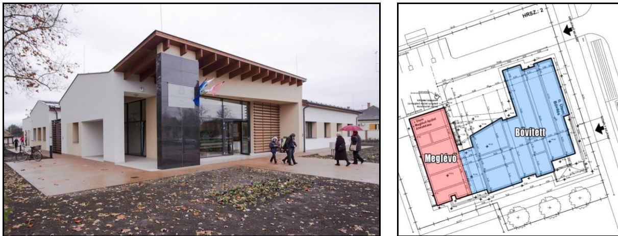
1. ábra. A vizsgált épület és kialakítása
