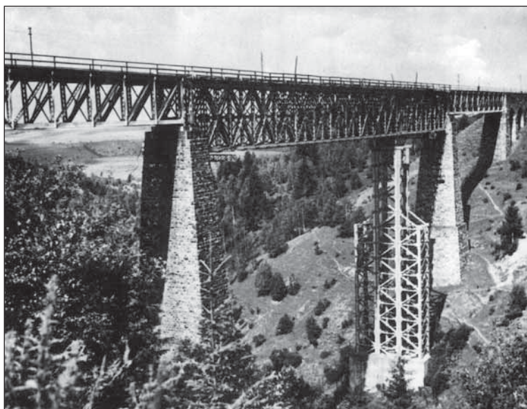
A tábori vasútrezd által ideiglenes jelleggel helyreállított Karakó-völgyhíd (A fotó Nemeskéri-Kiss: i. m. 172. oldaláról származik)
