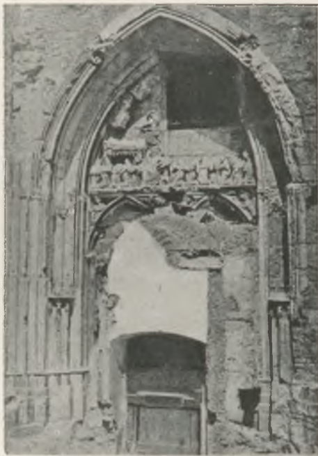
BUDAVÁRI FŐTEMLOM MÁRIA KAPUJA HELYREÁLLÍTÁS ELŐTT
