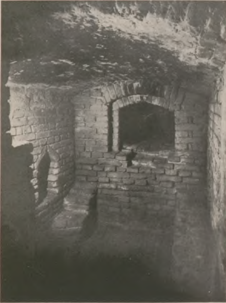
A vasvári gyógyszertár pincéjében levő fűtőberendezés előkamrája („praefurnium“). Installation de chauffage („praefurnium“) sous la cave de la pharmacie de Vasvár.
