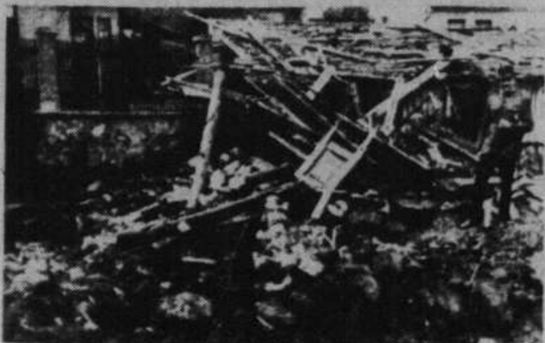
17. ábra. A 16. sz. bomba rombolása. A Miksa Kertm. ut. 16. sz. lakóháza; udvarra konyha-állványok
