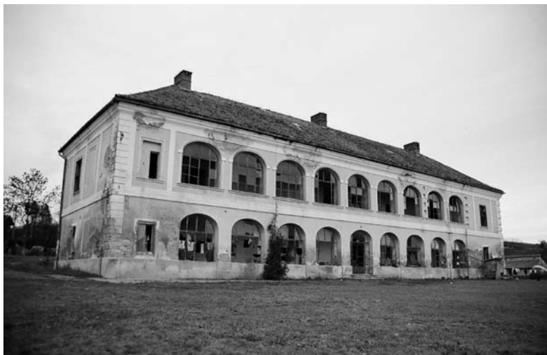
7. Az örményesi udvarház déli homlokzata (2006. november)
