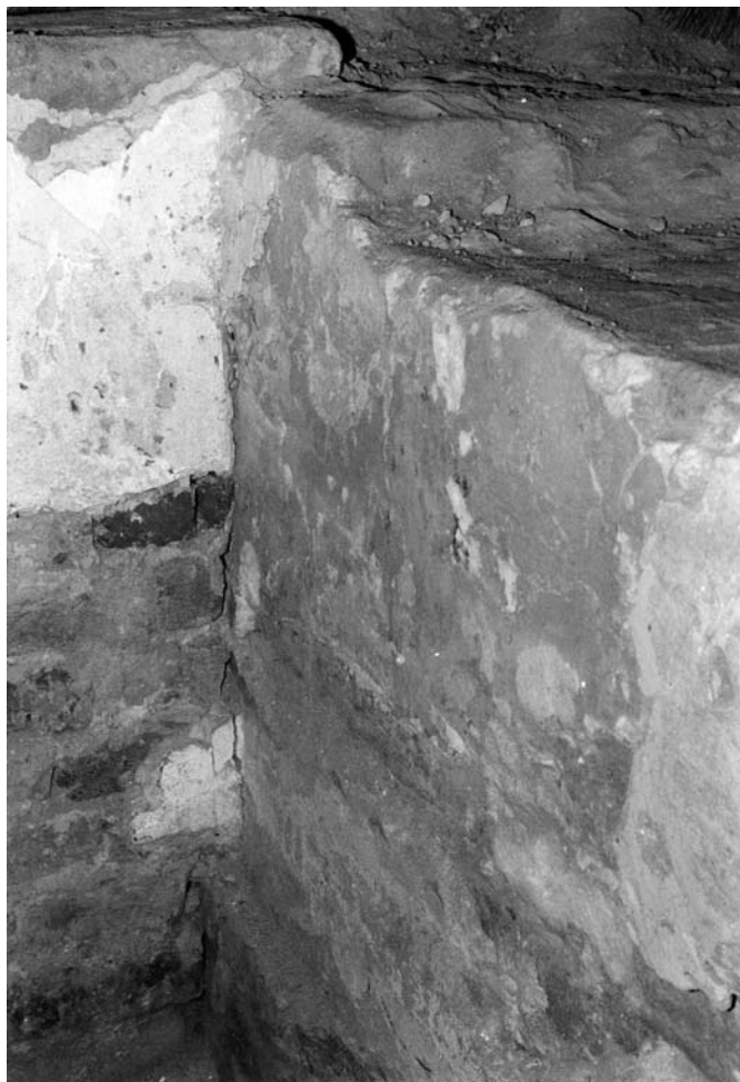
3. Az északi homlokzat feltárt részlete
