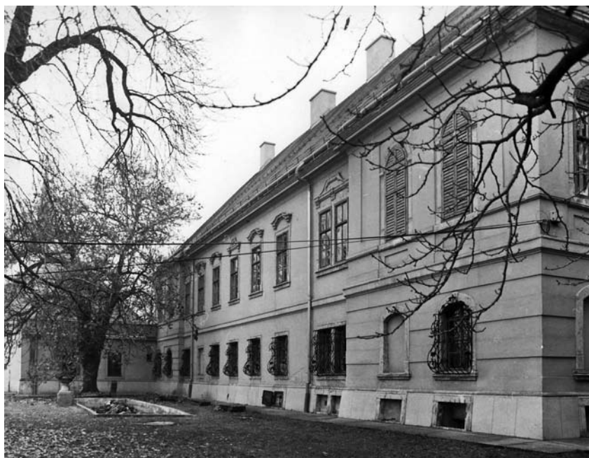
3. A kastély nyugati oldalhomlokzata (fotó: Szilágyi Edit)
