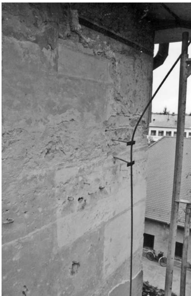
24. A főépületnek a déli torony építésekor elbontott első periódusú főpárkánya és a helyén húzódó kváderfestés (Juan Cabello felvétele)
