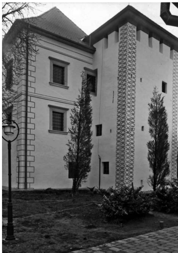
28. Az első periódusú épület északi homlokzata és az északi torony a 2004. évi helyeállítás után (Galacanu Efstatia felvétele)
