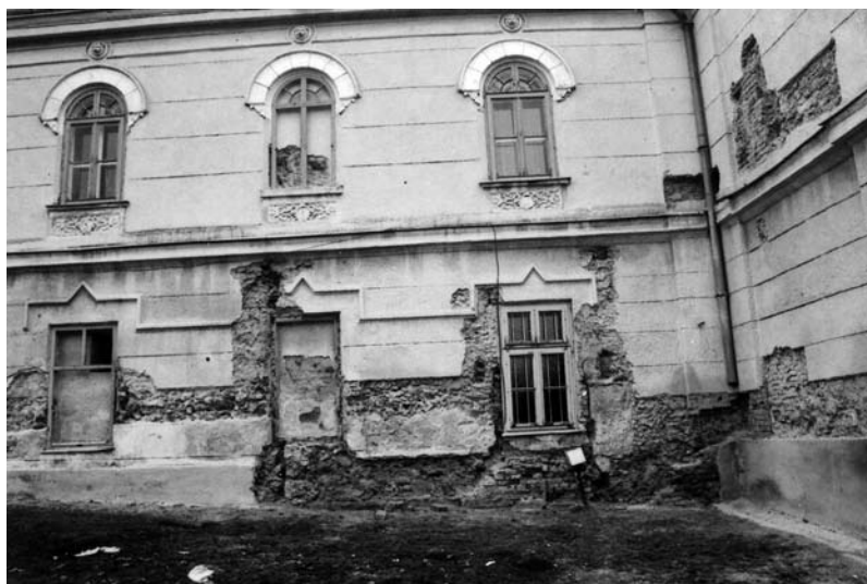
6. A főépület északi homlokzata: az 1. periódusú épület északkeleti sarka és bejárata (a szerző felvétele)
