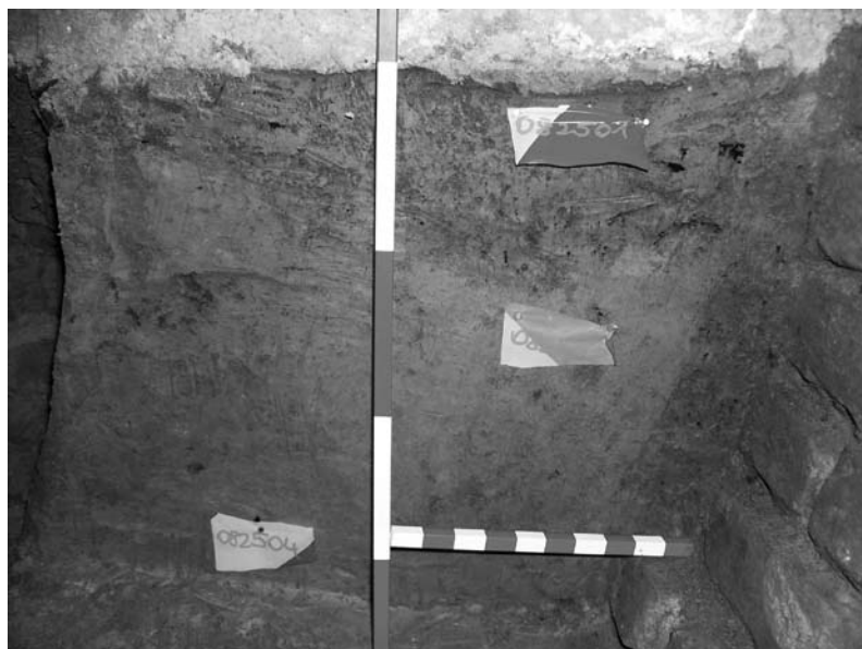
6. A kastély déli homlokzati falának alapozása a kastélybelsőben kialakított 25. árokban. A sárga agyagrétegbe és a felette elhelyezkedő faszenes szürke rétegbe egyaránt bevágták a kastély téglafalát (fotó: Koppány András)
