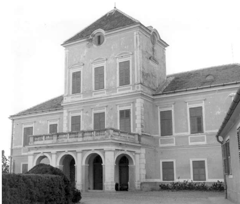
1. A főhomlokzat 1957-ben (KÖH Fotótár)
