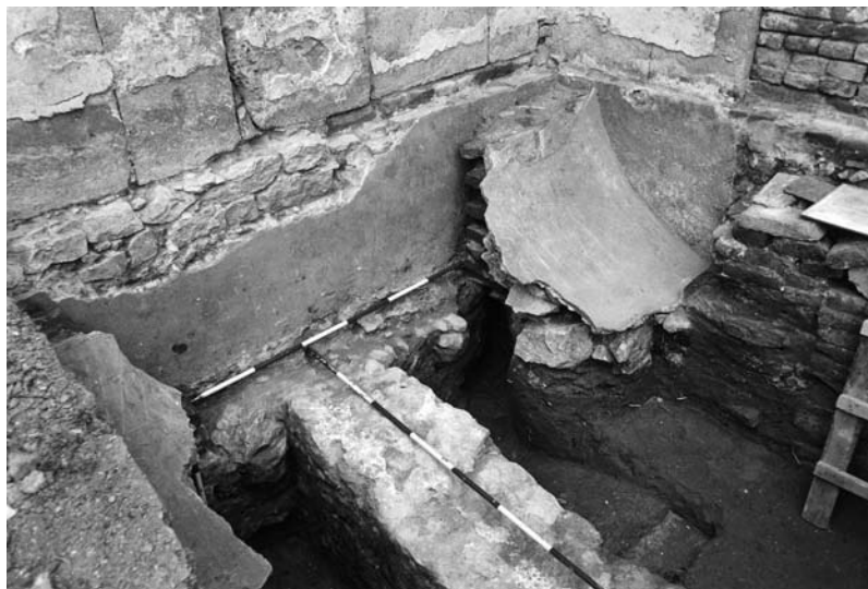
9. A déli homlokzat keleti végében feltárt „konzolpár”. Az épülethez merőlegesen csatlakozó fal barokk falazat (fotó: B. Benkhard Lilla)
