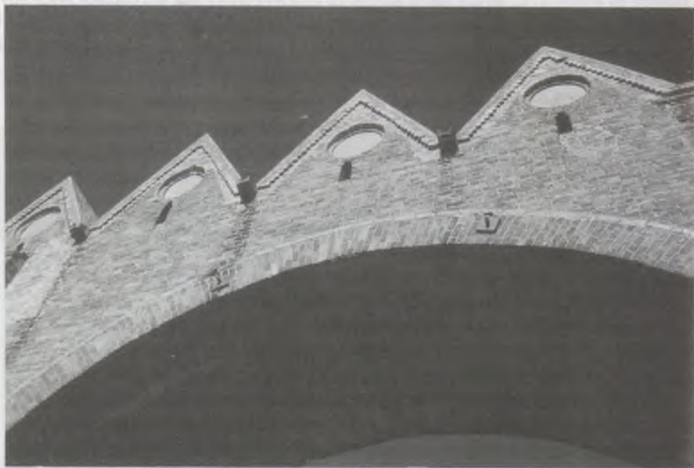
5. Thorn — die Danskeranlage mit glasierten Mauersteinen.
