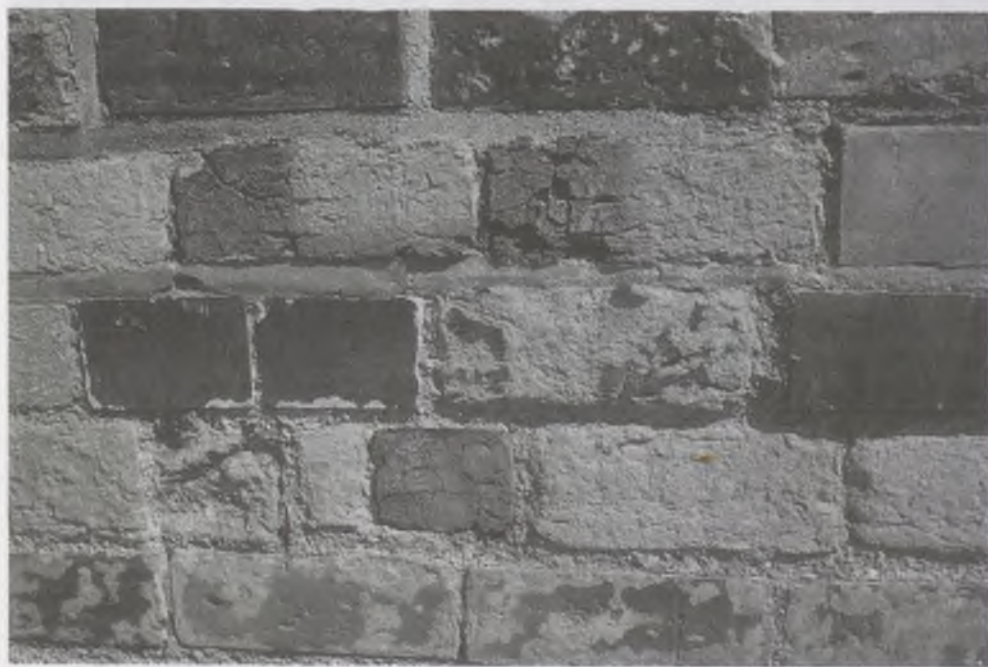
8. Pasewalk, Pfarrkirche — Backsteine im Mauerverband, von denen Teile schwarz gebrannt wurden.
