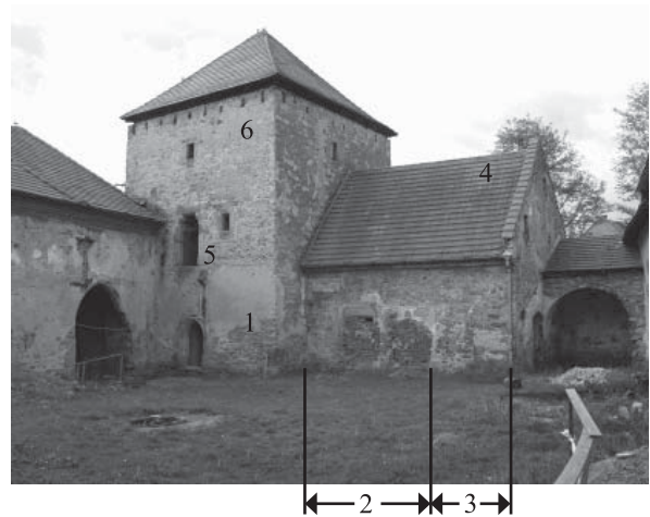
Abb. 7: Blick in die südwestliche Ecke des Hofes, links die Durchfahrt, daneben der Turm der Bauphase II, in der Bauphase IIIa und IIIb ungenutzt. 1 – im Erdgeschoss des Turmes in Bauphase II nur Lagerräume, in Phase IIIa Kanzlei, in Phase IIIb Kammer der Wohnung; 2 – Zubau der Wohnung der Phase III – Umfang der Stube; 3 – Zubau der Wohnung der Phase III – Umfang der Eingangsdiele; 4 – Dachgeschoss mit Zutritt auf den Wehrgang; 5 – Eingangsportal im ersten Obergeschoss des Turmes, Bauphase II, in der Bauphase III zugänglich mit Hängengang von Dachgeschoss des Südflügels; 6 – Abdrücke der Knaggen des ehemaligen Fachwergeschosses, vergl. Abb. 1 (Foto: M. Rykl).
