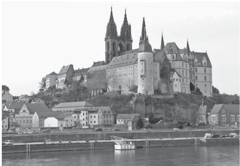
Abb. 7: Meißen, Burgberg über der Elbe von Südosten mit (von links nach rechts) Dompropstei, den Domtürmen, dem Liebenstein und östlichen Annexbauten des Doms sowie dem Südtrakt, Kapellenturm und Nordostbau der Albrechtsburg (Foto: Architekturbüro Donath, 2010). Fig. 7: Meissen, Castle Hill on the Elbe from the southeast with (from left to right) the Cathedral Chapter, the cathedral towers, Liebenstein and eastern extensions of the cathedral as well as the south wing, chapel tower and northeastern building of Albrechtsburg Castle (photo by Architekturbüro Donath, 2010).
