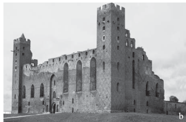
Abb. 1: Reden/Radzyń, Konventshaus; a – Grundriss des Hauptgeschosses (nach Steinbrecht 1888, Abb. 81), b – Ansicht von der Süd-Ost-Seite (Foto: K. Pospieszny).
