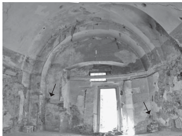
Abb. 10: Raum zwischen dem Saal und der Kapelle, Blick nach Westen. Die Pfeile zeigen auf die Sonden, in denen beidseitig Spuren der dünnen Konstruktion gefunden sind (Foto: M. Rykl).
