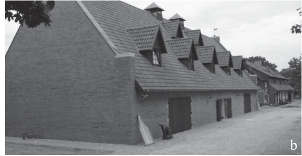
Abb. 12: Marienburg/ Malbork, nördliche Vorburg; a – archäologisch entdeckte ordenszeitliche Mauern und Verpflasterung bei der Gießerei (Foto: K. Pospieszny), b – das neue Museumsmagazin bei der Gießerei (Foto: K. Pospieszny).
