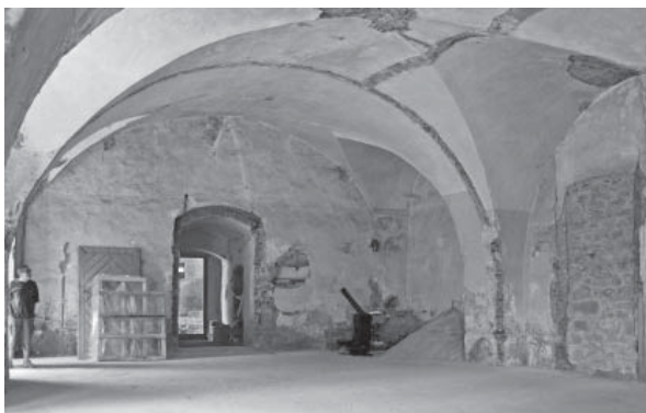
Abb. 9: Saal, sog. „Große Stube“, Blick nach Westen. Rechts in der Ecke Platz des ehemaligen Kachelofens mit Sitzbank, oberhalb des Gewölbes des Kellerhalses. Das Gewölbe der Großen Stube stammt erst aus der Bauphase IV, aus der zweiten Hälfte des 16. Jahrhunderts (Foto: M. Rykl).
