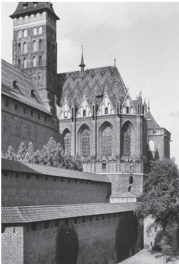
Abb. 10: Marienburg/Malbork, Ostseite des Konventshauses nach der Restaurierung Steinbrechts in 1896 (Archivfoto, Schlossmuseum Malbork/Marienburg).
