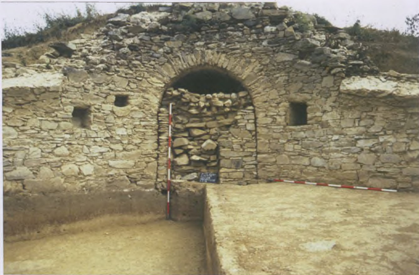
Abb. 13: Sachsenhof: Südlicher Wehrturm (Photo: M. Krenn).
