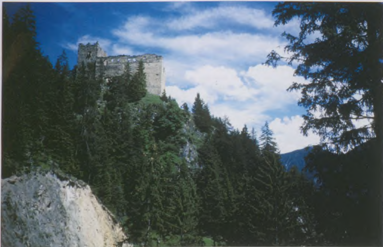
Abb. 16: Belfort GR: Hier wurde 1222 «in castro» eine Urkunde ausgestellt. Wie die jüngst durchgeführte Bauuntersuchung und die Resultate der Dendrodatierungen zeigten, begann man aber erst 1229 mit dem Bau der Burg (Photo: W. Wild).
