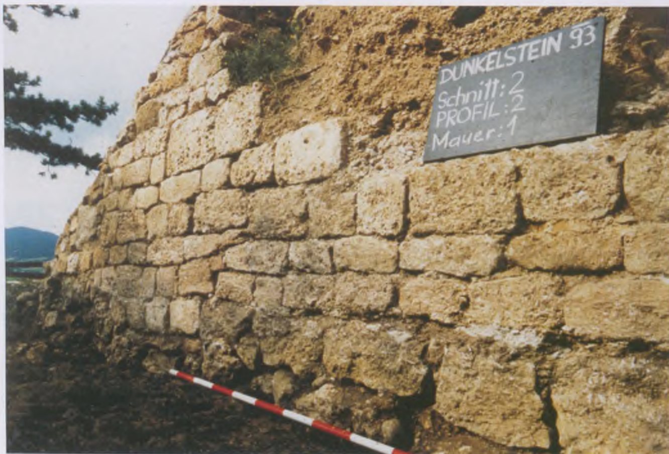
Abb. 5: Burg Dunkelstein: Die Südmauer des Wohnbaues (M1), Außenseite (Photo: K. Kühtreiber).
