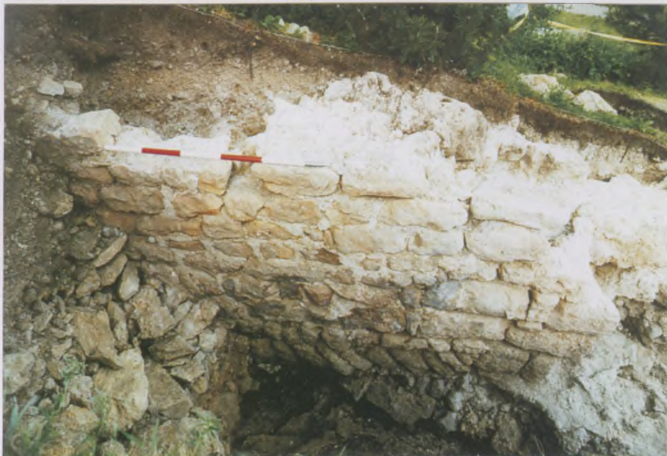
Abb. 4: Burg Dunkelstein: Die Innenseite des Nordberings auf Höhe des Wohnbau-Ostbereiches (Photo: K. Kühnreber).
