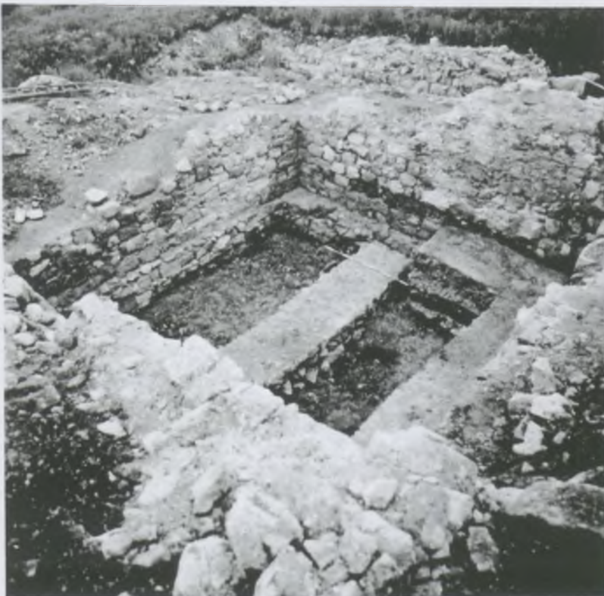
Abb. 8: Stari grad oberhalb Podbočje: Fundamentmauern der ersten Bauphase der Burg unter dem Turm aus dem 13. Jahrhundert (Photo: S. First).
