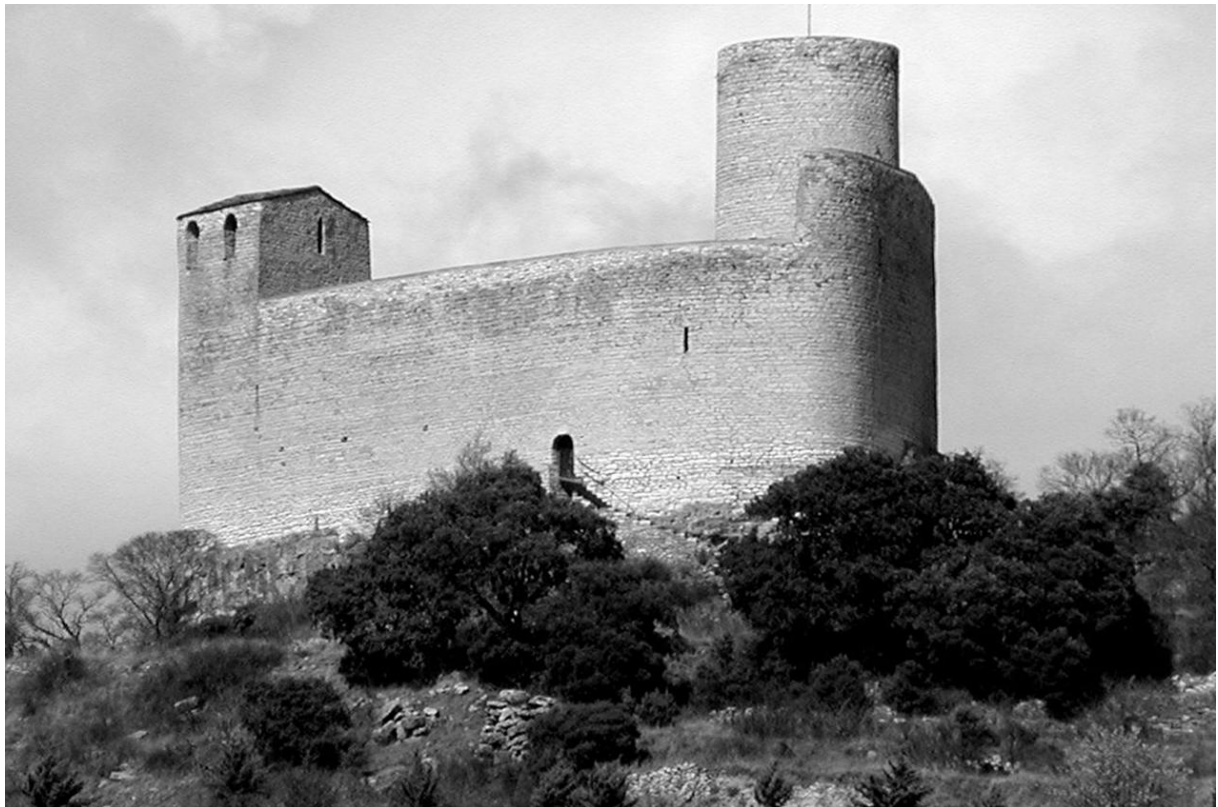
Abb. 6 Castell Mur / Katalonien, Kernburg mit Turm
