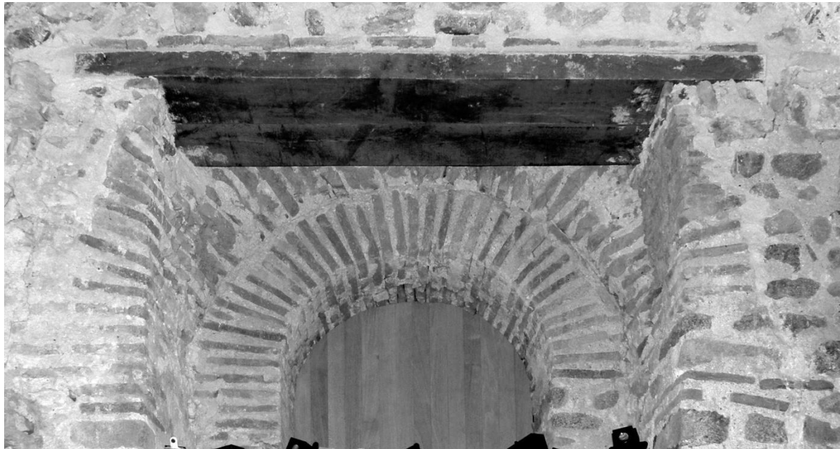
Abb. 2 Mayenne, Fensteröffnung im Turm
