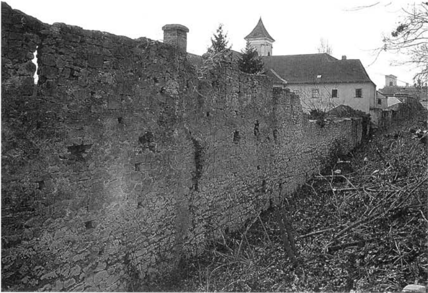
Abb. 1. Abschnitt der Stadtmauer im Norden der Stadt. Im Hintergrund der Baublock des Franziskanerklosters. Aufnahme: BDA, F. Sauer.
