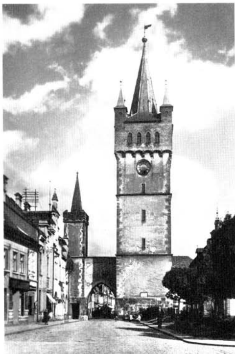
Abb. 5. Vysoké Mýto. Prager Tor der Stadtbefestigung.
