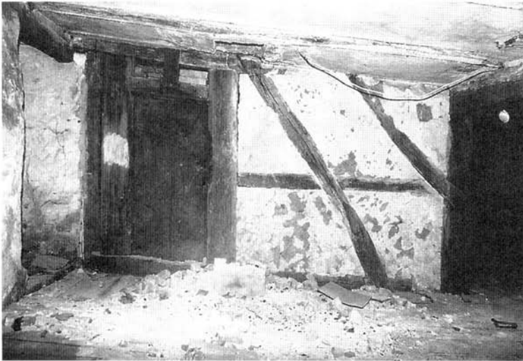
Abb. 10. Schloß Gomaringen, Südflügel, Querwand in der oberen Geschoßebene des Unterbaues mit Fachwerkgerüst des frühen 14. Jahrhunderts (Ständer, Aussteifung, Schwelle und Deckengebälk). Die Wandbildung und die Bohlentür entstammen der zweiten Hälfte des 15. Jahrhunderts. Aufnahme: S. Uhl.
