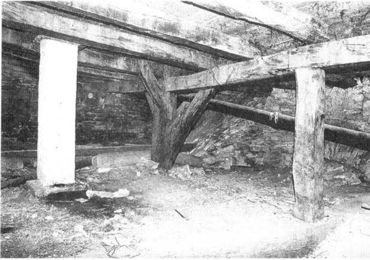
Abb. 9. Schloß Gomaringen, Südflügel, Blick in die untere Geschoßebene des Unterbaues mit dem Fachwerkgerüst des frühen 14. Jahrhunderts. Aufnahme S. Uhl.
