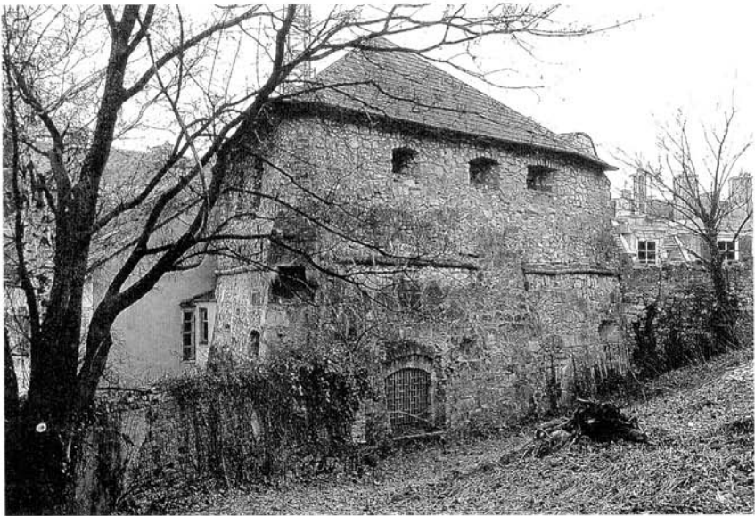
Abb. 18. Ansicht des „Pulverturmes“ von Norden. Aufnahme: BDA, F. Sauer.
