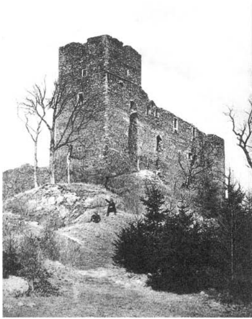
Abb. 9. Burg Radyně. Kern der Burganlage im Jahre 1923.
