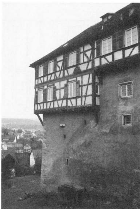
Abb. 1. Schloß Gomaringen, Blick auf des östliche Kopfende des Südflügels. Die Ringmauer entstammt dem 13. Jahrhundert, die weite Auskragung des Oberbaues geht auf das frühe 14. Jahrhundert zurück, das Fachwerk der Obergeschosse entstand ab der zweiten Hälfte des 16. Jahrhunderts. Aufnahme: S. Uhl.
