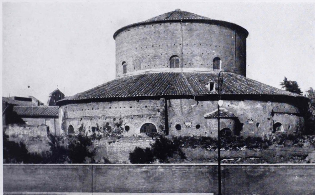
4. A befalazott körüljáró és a nyugati apszis. A képen jól látható a külső folyosó dongaboltozatainak a vállvonala, fölötte a fedél szarufáinak a helyei. L'ambulacro murato e l'abside occidentale. Sulla fotografia si distingue bene la linea d'imposta della volta a botte del corridoio esterno, con sopra il posto dei panconcelli della copertura.
