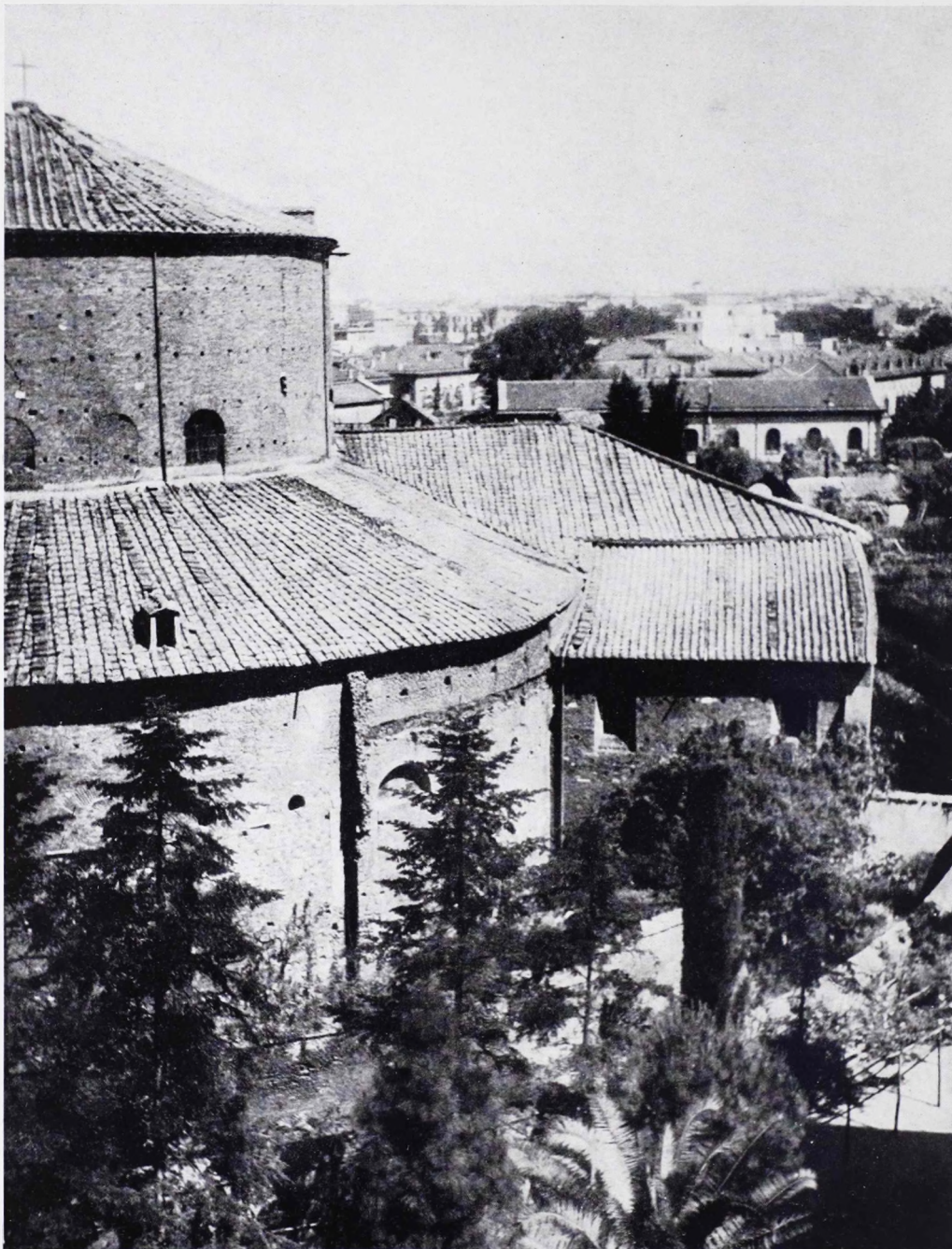
41. A Szent István kápolna (két ablakos) a Mártírok kápolnához támaszkodik. Jól látható a kereszt-szárnyak eredeti lefedése és a kápolna fedelének csatlakozása a körüljáróhoz.
