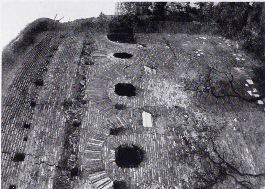
20. A körüljáró fala a külsőfolyosó helyén. Megfigyelhető a boltózat vállvonala és indítása az oldalfal felé. A vegyes alsó falazatrész és a kezdetleges körablakok a XV. század elejére vallanak.
