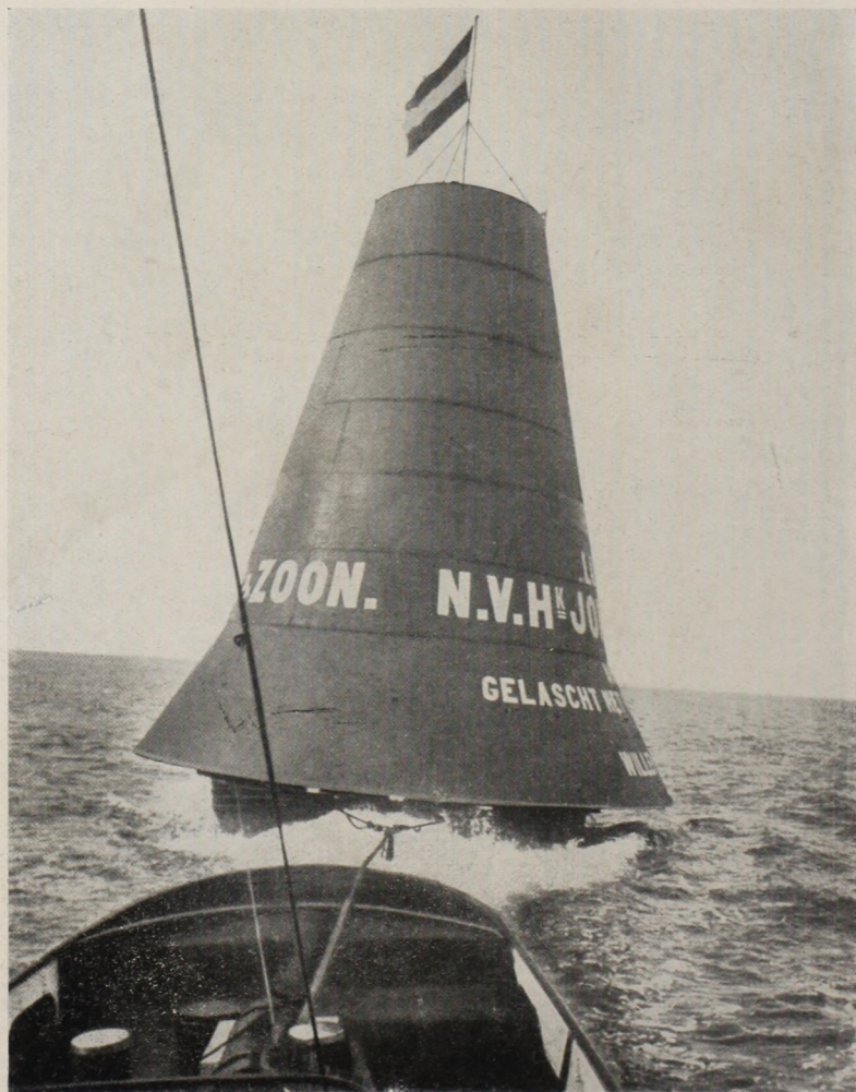
Hatalmas acélkúp, amelyet a «Lutin» kincseinek kiemelésére Amsterdamban készítettek. (Súlya 17,000 kg.)
