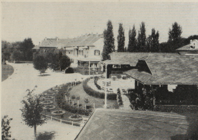
25. kép. A székesfőváros kenesei üdülotelepe, a főépület erkélyéről nézve. Elöl az étterem és tánchely, hátul a régibb lakóépület. Ez az egyetlen, igazán modern üdülotelep a Balaton mellett. (Szerző fényképe.)
